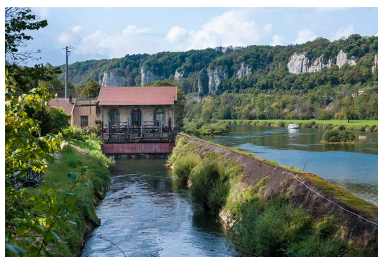
Vue depuis le canal d'amenée. Phot. Jérôme Mongreville IVR43_20142501148NUC4A
