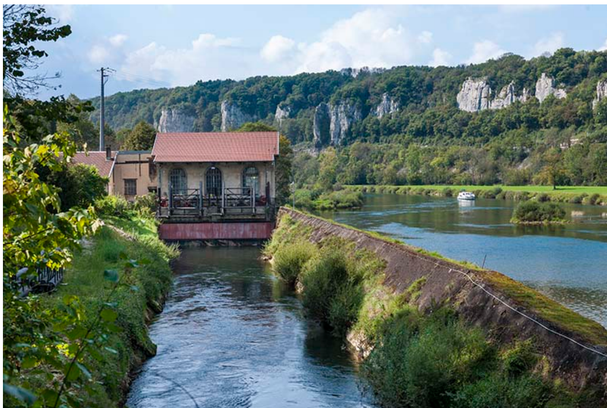
Vue depuis le canal d'amenée.
