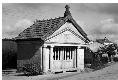
Oratoire du Dieu-de-Pitié situé à l'angle de la Grande Rue et de la rue de la Pitié. Phot. Yves Sancey IVR43_19802501035X
