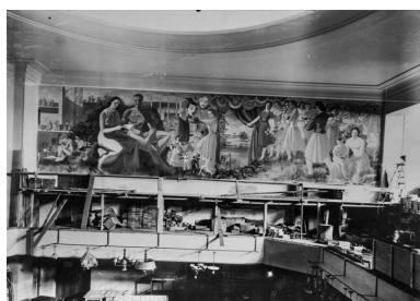
[Peinture côté cour, lors de l'affectation aux Ets James et Soisson]. S.d. [entre 1942 et 1946]. Phot. Pierre-Marie Barbe-Richaud, Autr. auteur inconnu IVR26_20238900992NUC4A
