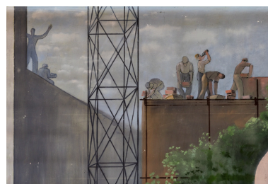
Peinture côté cour : les constructeurs, détail des maçons. Phot. Pierre-Marie Barbe-Richaud IVR26_20238900933NUC4A
