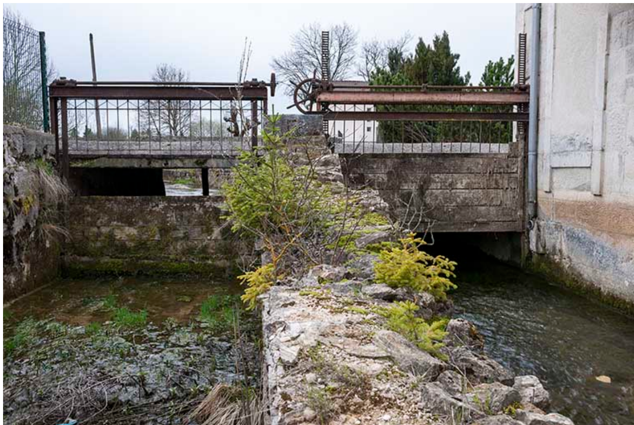
Vestiges du local des turbines.
