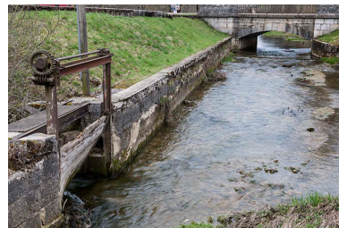
Canal d'amenée et vanne de décharge. Phot. Jérôme Mongreville IVR43_20162500290NUC4A
