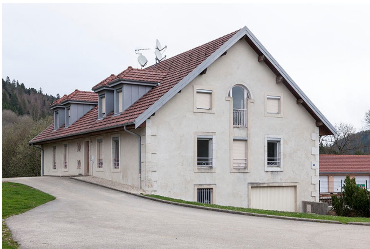
Vue depuis le sud-ouest.
