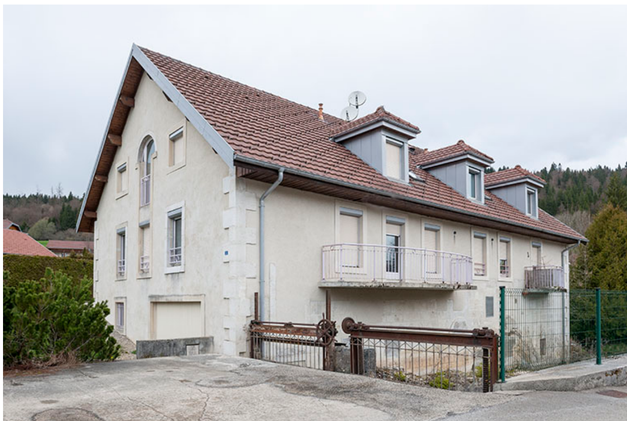
Vue depuis le sud-est.
