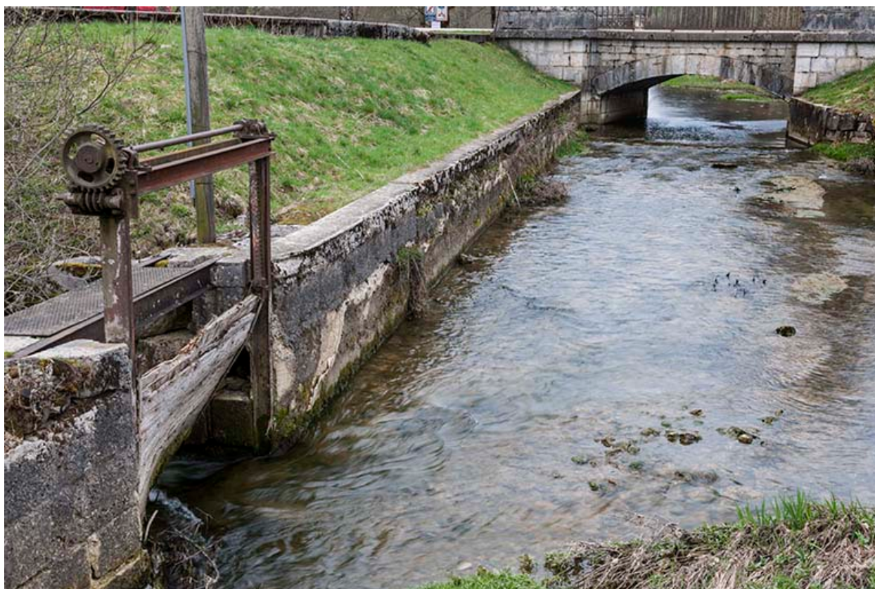
Canal d'amenée et vanne de décharge.
