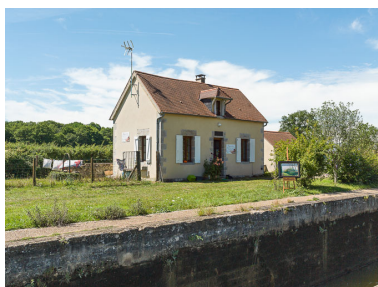
Vue du sas et de la maison éclusière. Phot. Pierre-Marie Barbe-Richaud IVR26_20175800347NUC2A
