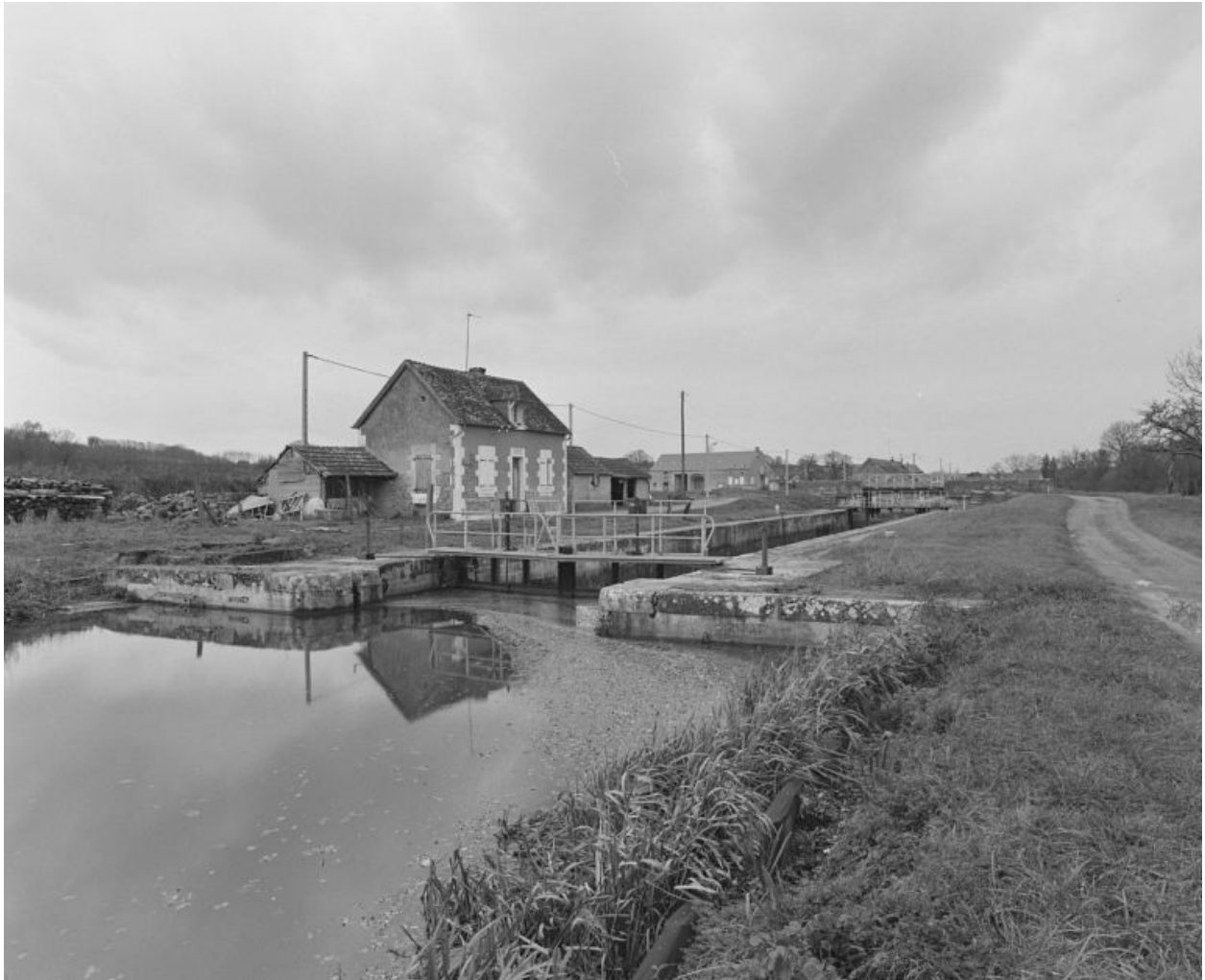
L'écluse n°33, dite de Mont : vue d'ensemble prise de l'amont en 1992.
