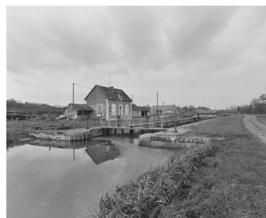
L'écluse n°33, dite de Mont : vue d'ensemble prise de l'amont en 1992. Phot. Jean-Luc Duthu IVR26_19925800275X
