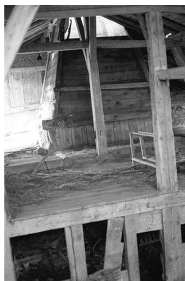
Charpente et "tué". Phot. Gilbert Poinot IVR43_19752500960Z
