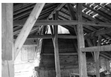
Charpente et "tué". Phot. Gilbert Poinot IVR43_19752500959Z
