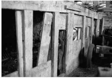
Aire de roulage. Phot. Gilbert Poinot IVR43_19752500956Z
