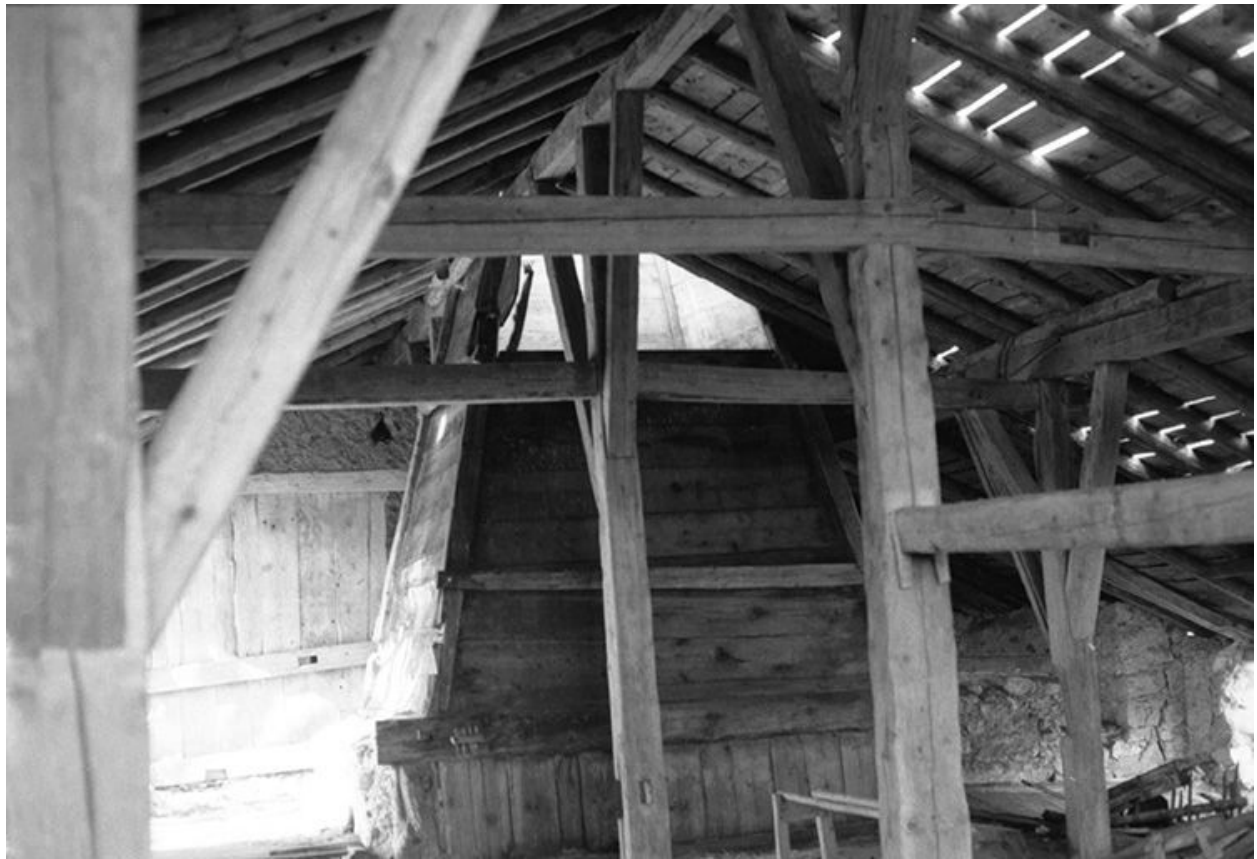
Charpente et "tué".
