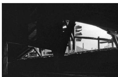
Charpente et "tué". Phot. Gilbert Poinot IVR43_19752500955Z
