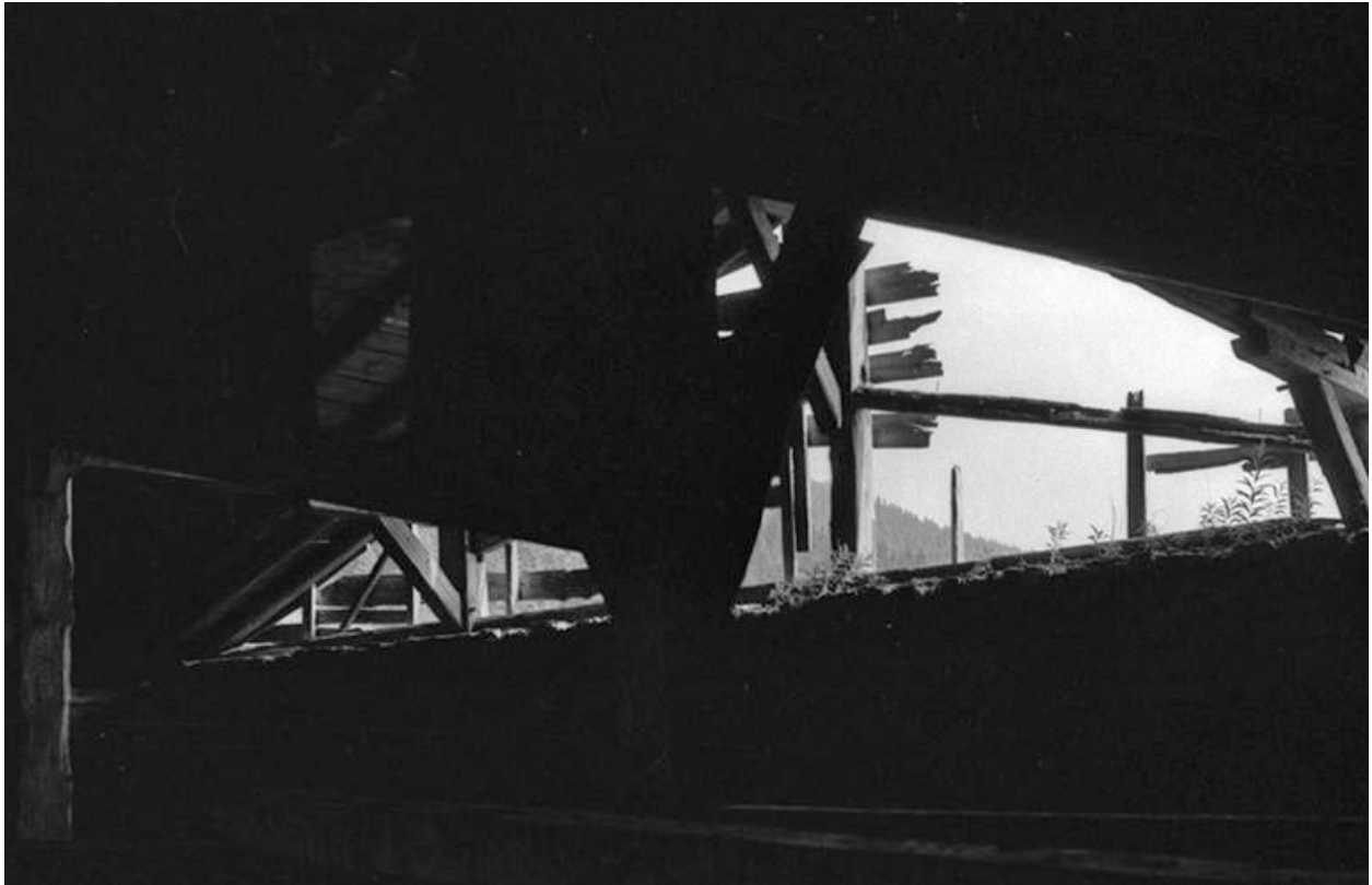
Charpente et "tué".
