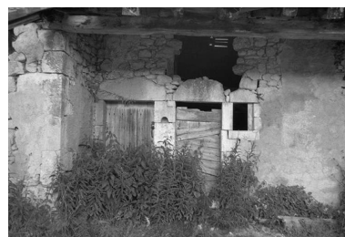
Porte d'entrée du couloir, porte d'entrée d'habitation. Phot. Gilbert Poinot IVR43_19752500947Z
