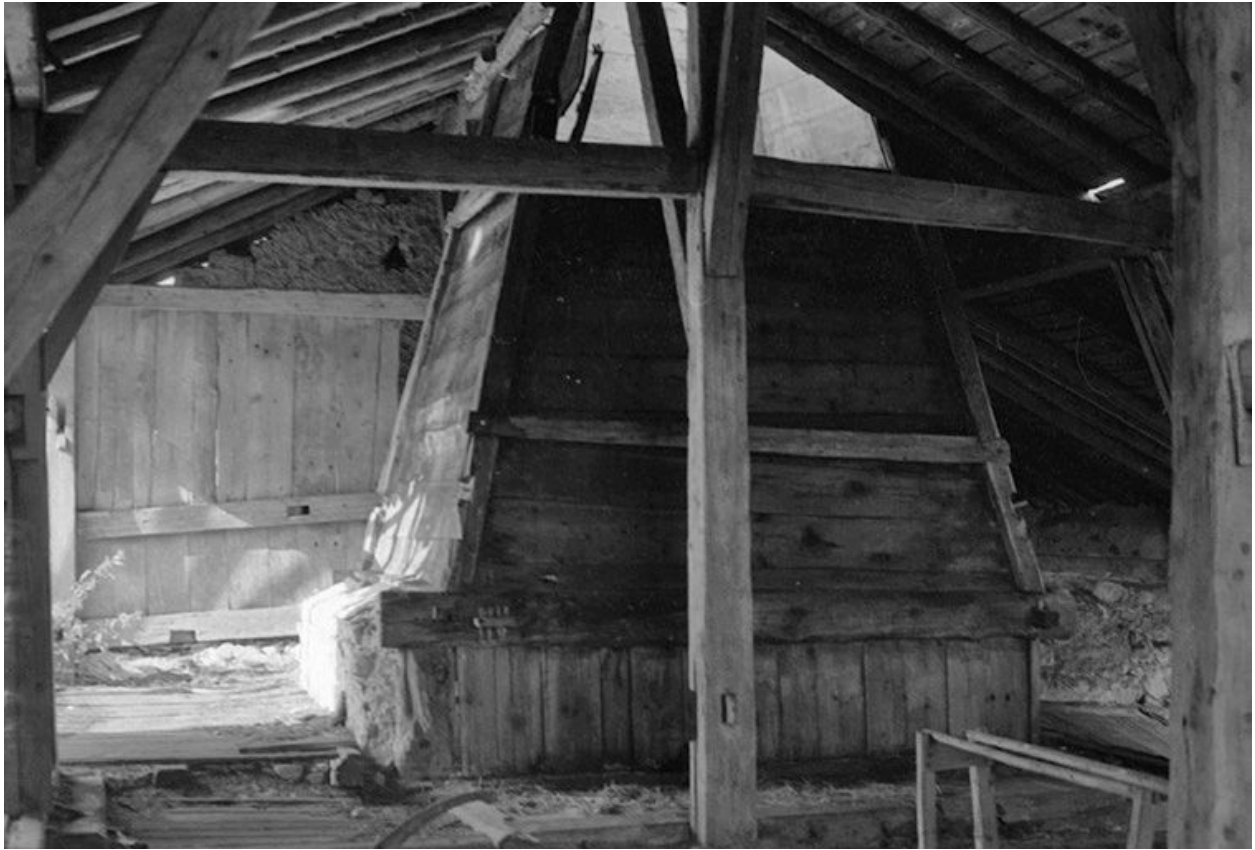
Charpente et "tué".
