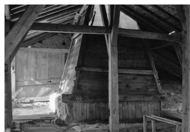
Charpente et "tué". Phot. Gilbert Poinot IVR43_19752500952Z
