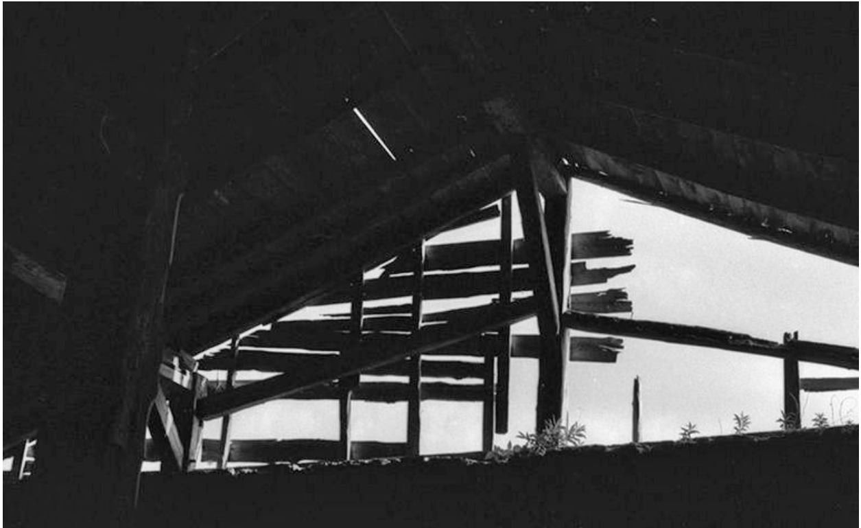
Charpente et "tué".
