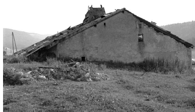
Façade latérale gauche. Phot. Gilbert Poinot IVR43_19752500942Z
