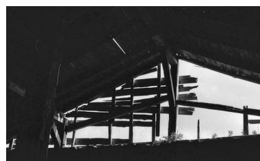
Charpente et "tué". Phot. Gilbert Poinot IVR43_19752500954Z
