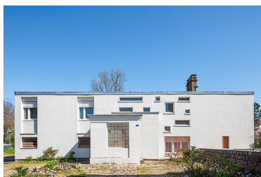
Presbytère. Vue d'ensemble. Phot. Aline Thomas IVR43_20212500345NUC4A
