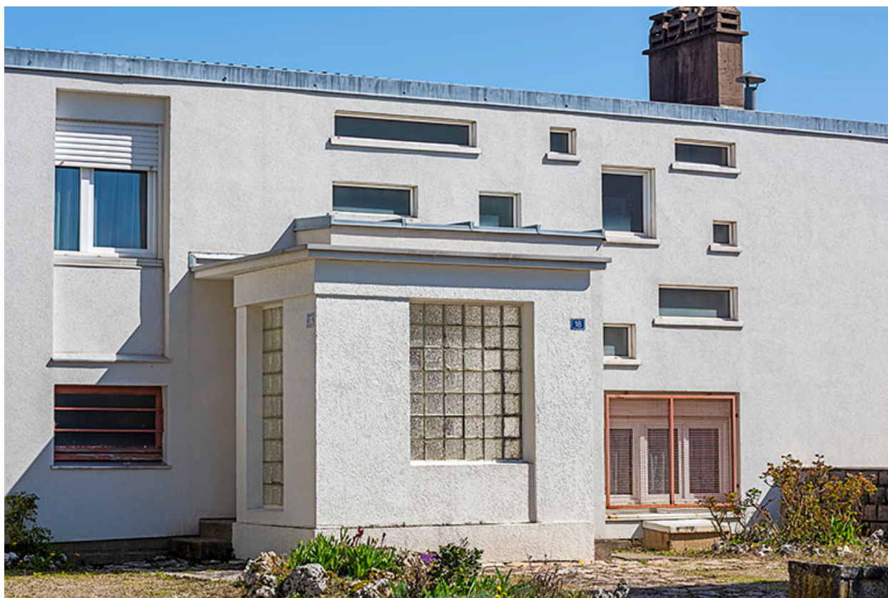
Presbytère. Détail de la façade sud-ouest, de trois quarts.
