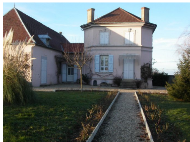
Vue d'ensemble de la façade.
