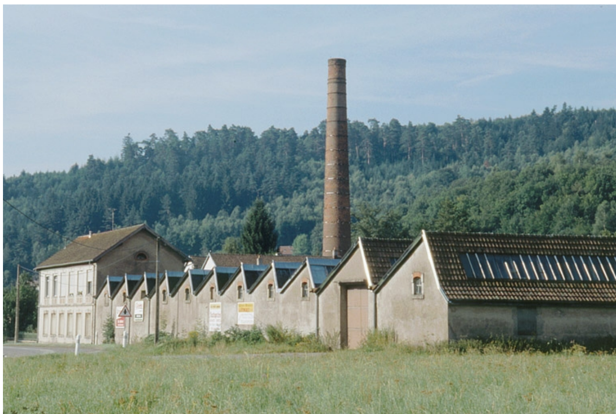
Façade sur la route départementale 465.
