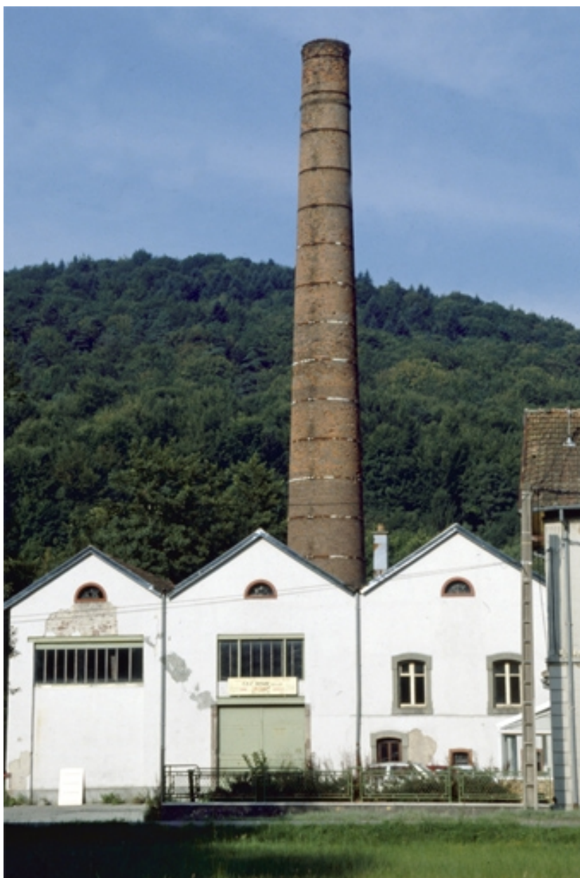
Salle des machines, chaufferie et cheminée.
