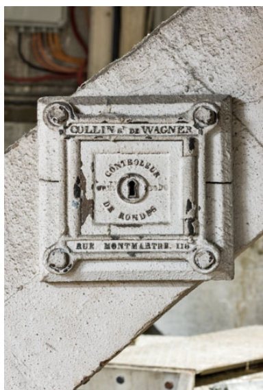
Contrôleur de ronde Collin (successeur de Wagner, 116 rue de Montmartre à Paris), dans le comble au-dessus de la salle. Phot. Pierre-Marie Barbe-Richaud IVR26_20222100643NUC4A
