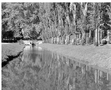
Vue d'ensemble, depuis l'ouest. Phot. Jérôme Mongreville IVR43_20032500094X
