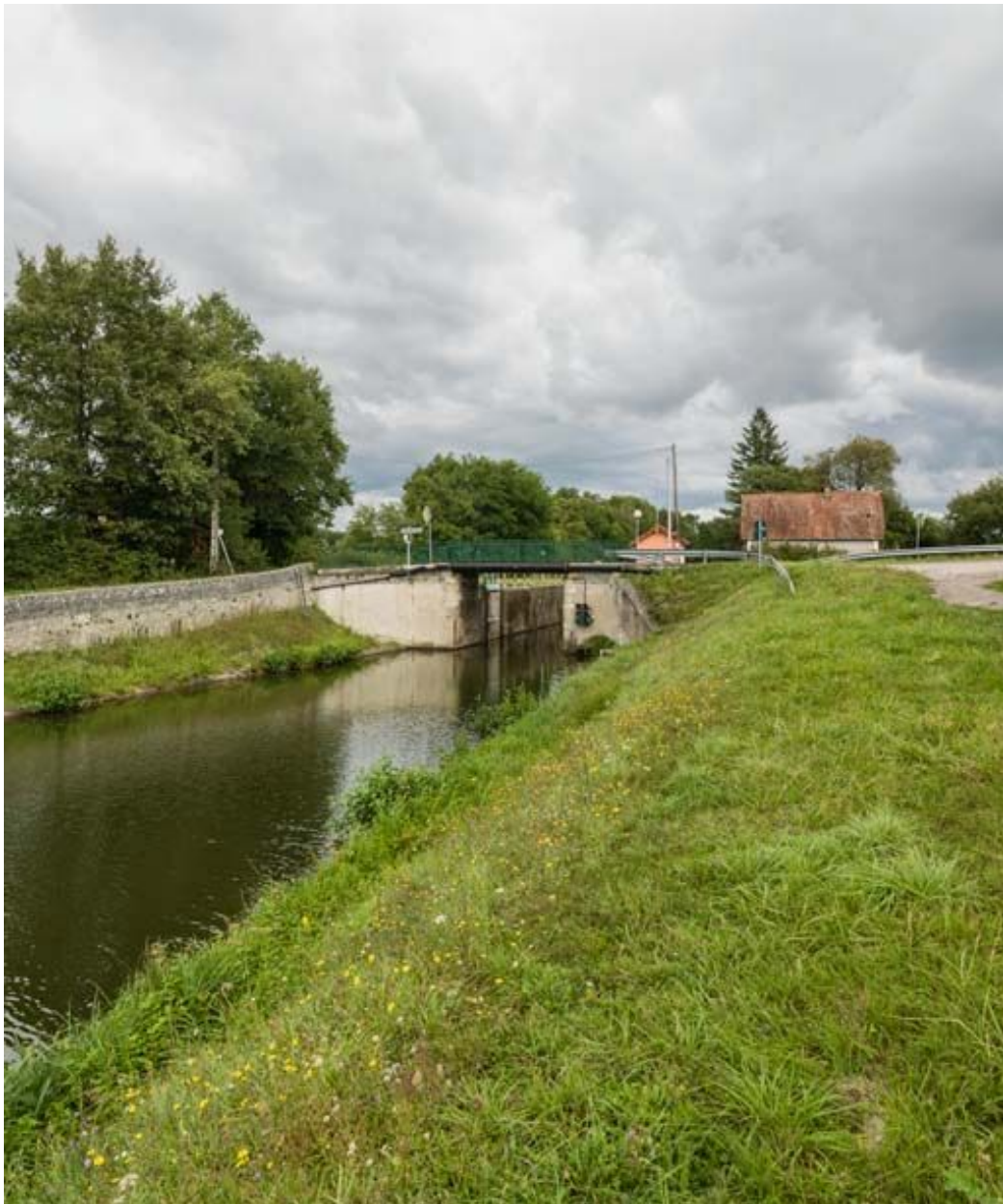
Vue d'ensemble du pont.
