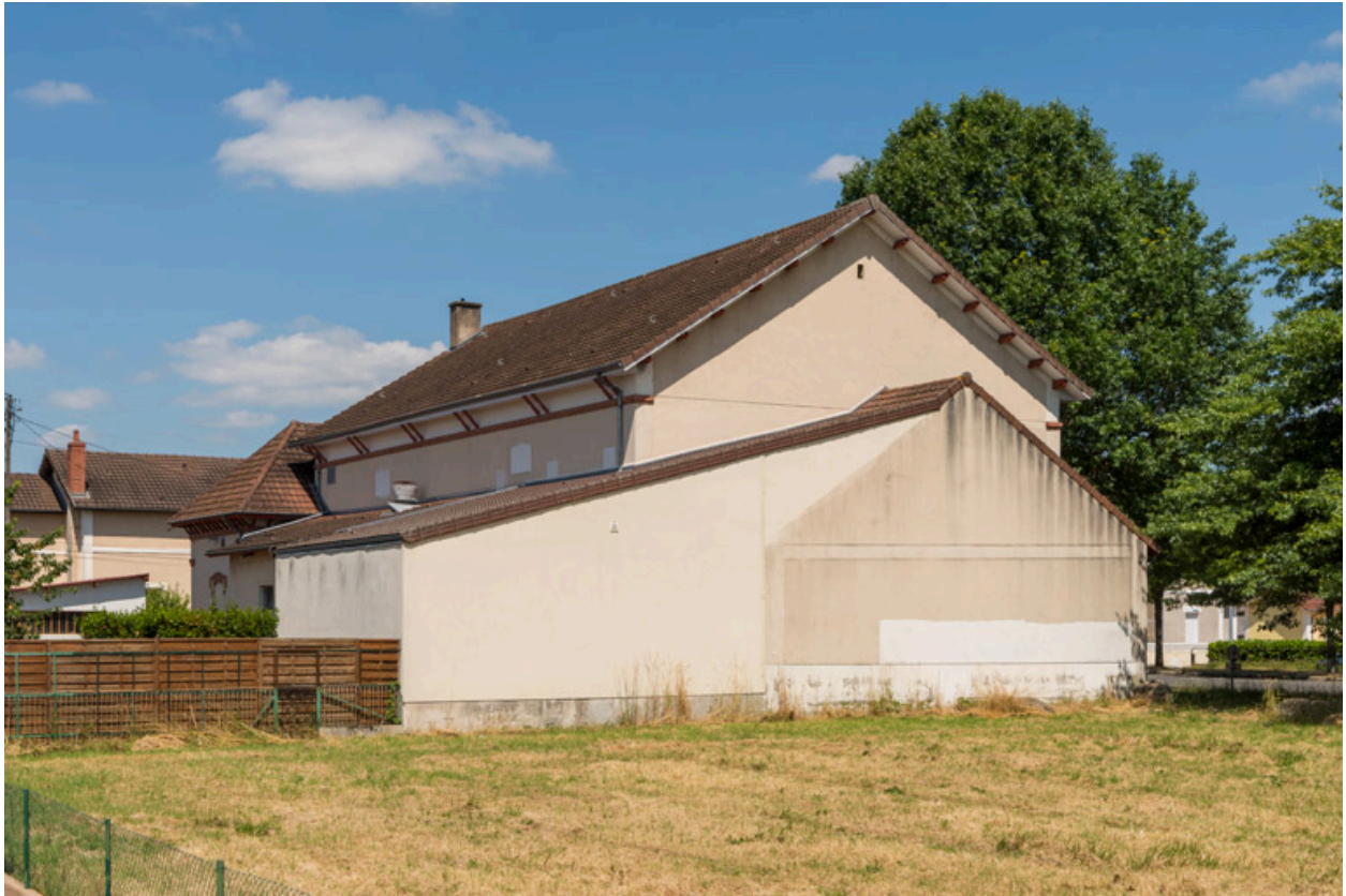
Façades postérieure et latérale droite.
