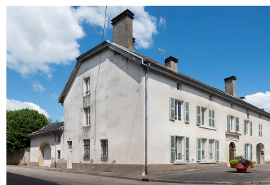
Le mur pignon sud. Phot. Jérôme Mongreville IVR43_20187000271NUC4A
