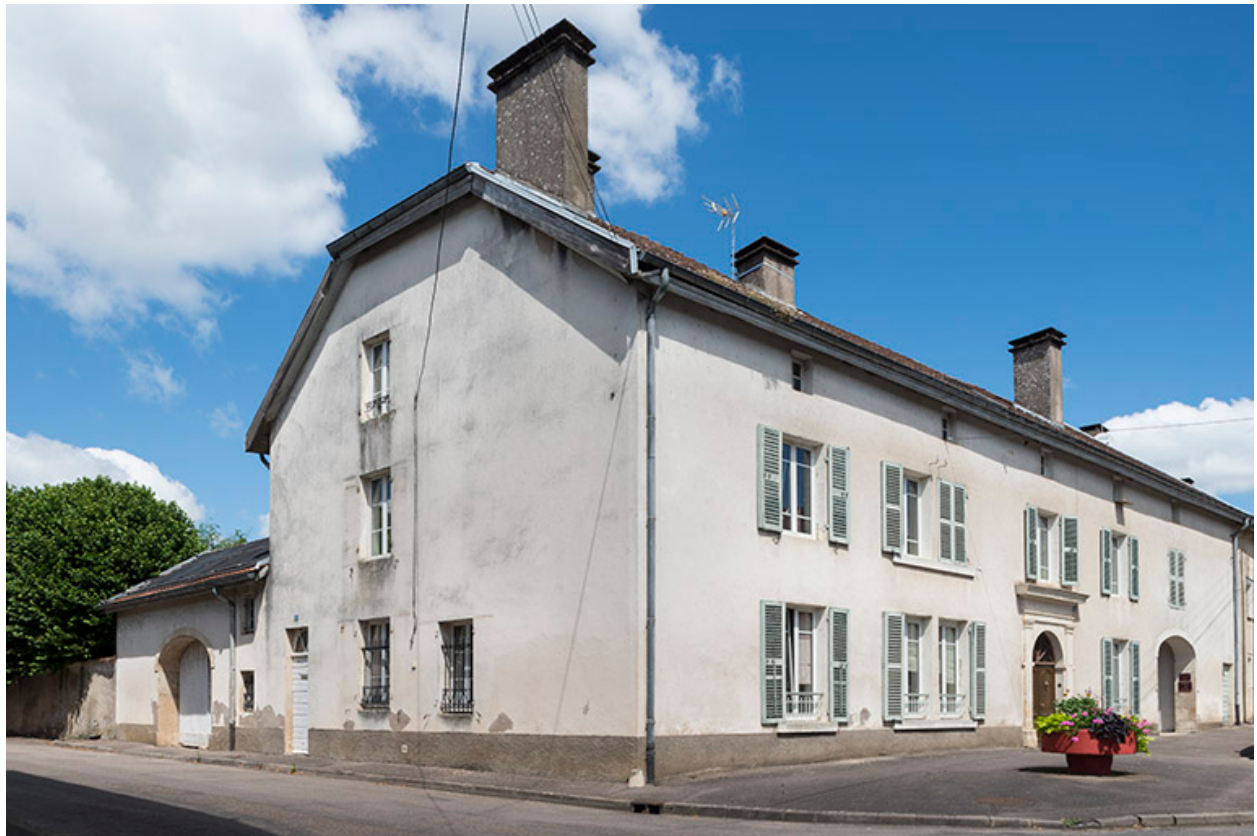
Le mur pignon sud.
