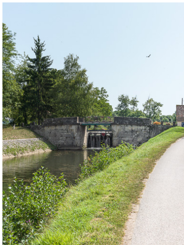
Vue du pont.
