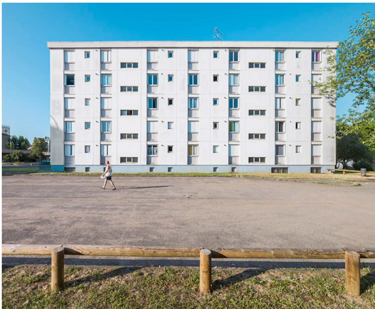
Bâtiment B-1, façade postérieure nord.
