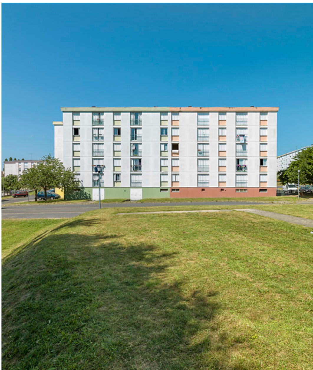
Bâtiment B-5, façade postérieure.
