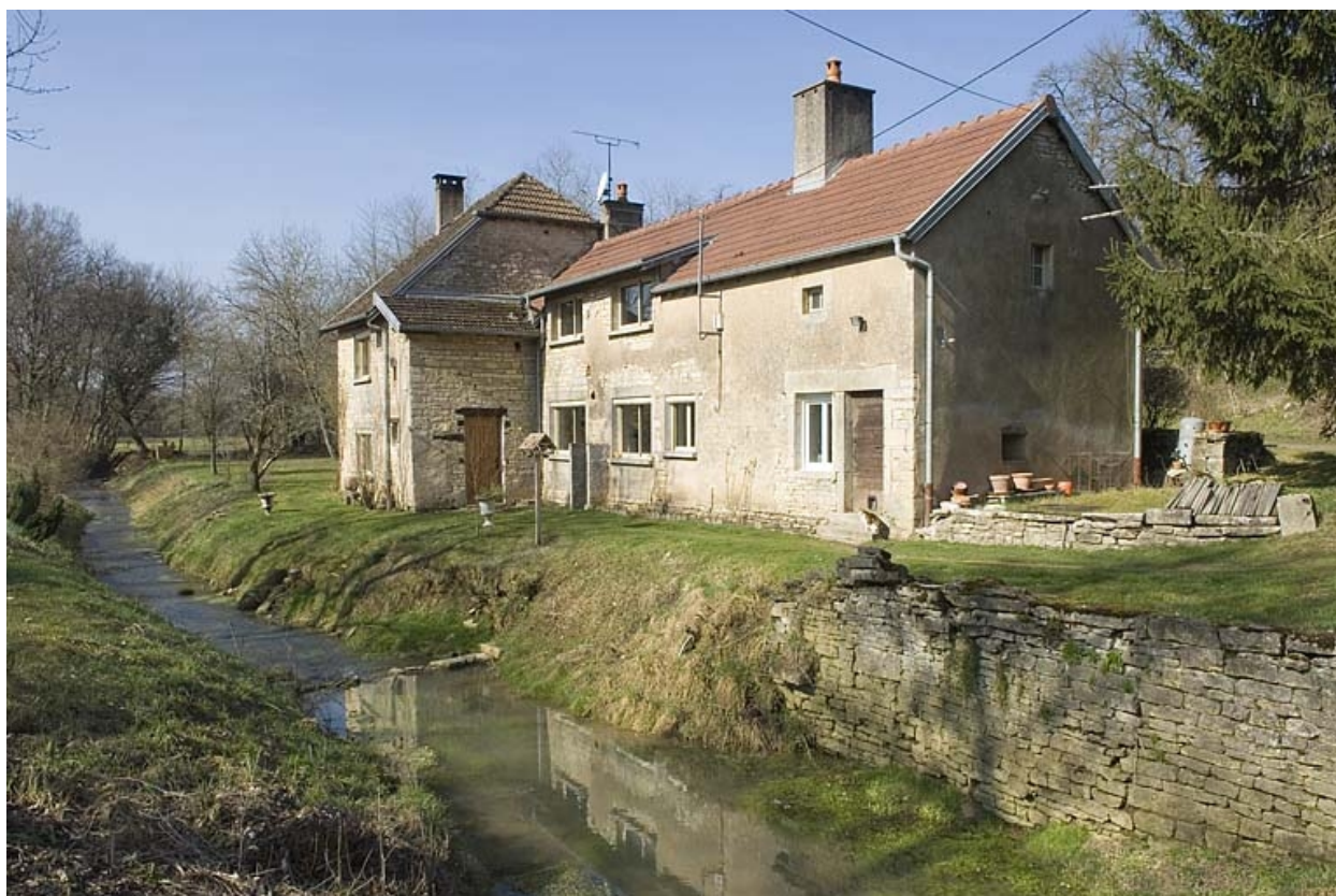
Logement depuis le bief de dérivation.
