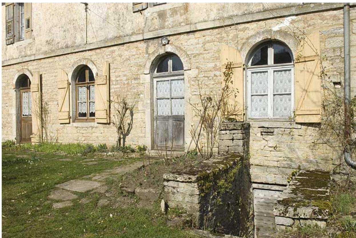
Détail de la façade du logement ouvrier.
