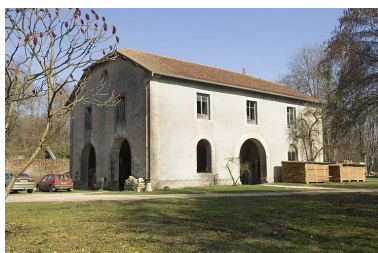
Bâtiment du haut fourneau depuis le sud. Phot. Jérôme Mongreville IVR43_20097000266NUC2A
