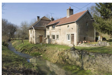
Logement depuis le bief de dérivation. Phot. Jérôme Mongreville IVR43_20097000263NUC2A
