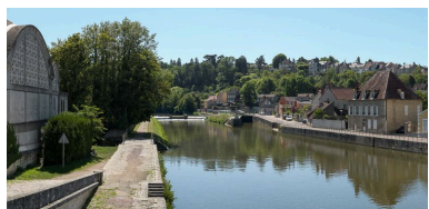
Le site d'écluse et le pertuis dans l'Yonne, vus d'aval. A gauche, on aperçoit Notre-Dame de Bethléem (IA58000661). A droite, la ville de Clamecy.
