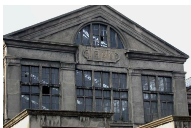
Élévation principale du bâtiments des alternateurs, détail. Phot. Alain Morelière IVR26_20047100006NUC2A
