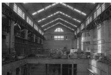
Pignon nord-ouest de la salle des machines vu depuis l'ancienne plate-forme des turboalternateurs. Phot. Frédéric Pillet IVR26_20007100384Z
