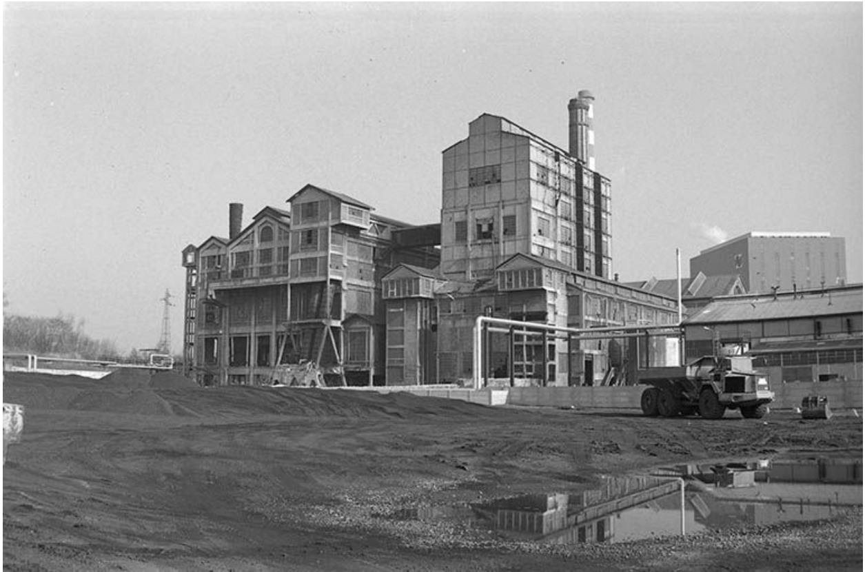
Les chaufferies, pignons sud.
