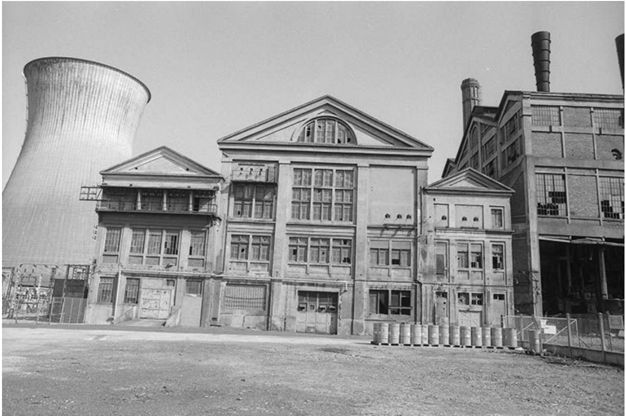
Façade postérieure de la centrale thermique de LUcy II (à droite les chaufferies, à gauche la tour de réfrigération de Lucy III).
