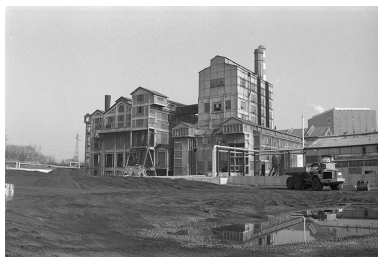
Les chaufferies, pignons sud.
