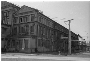
Le bâtiment des tableaux de distribution vu depuis l'est. Phot. Frédéric Pillet IVR26_20007100381Z
