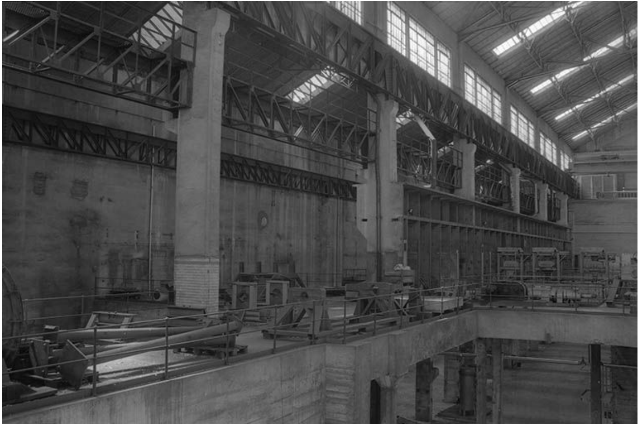
Le bâtiment des pompes vu depuis la salle des machines (ancienne plate-forme des turboalternateurs).
