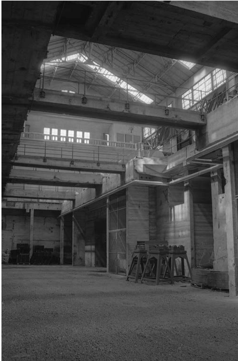
La salle des machines et les massifs formant la plate-forme des turboalternateurs.
