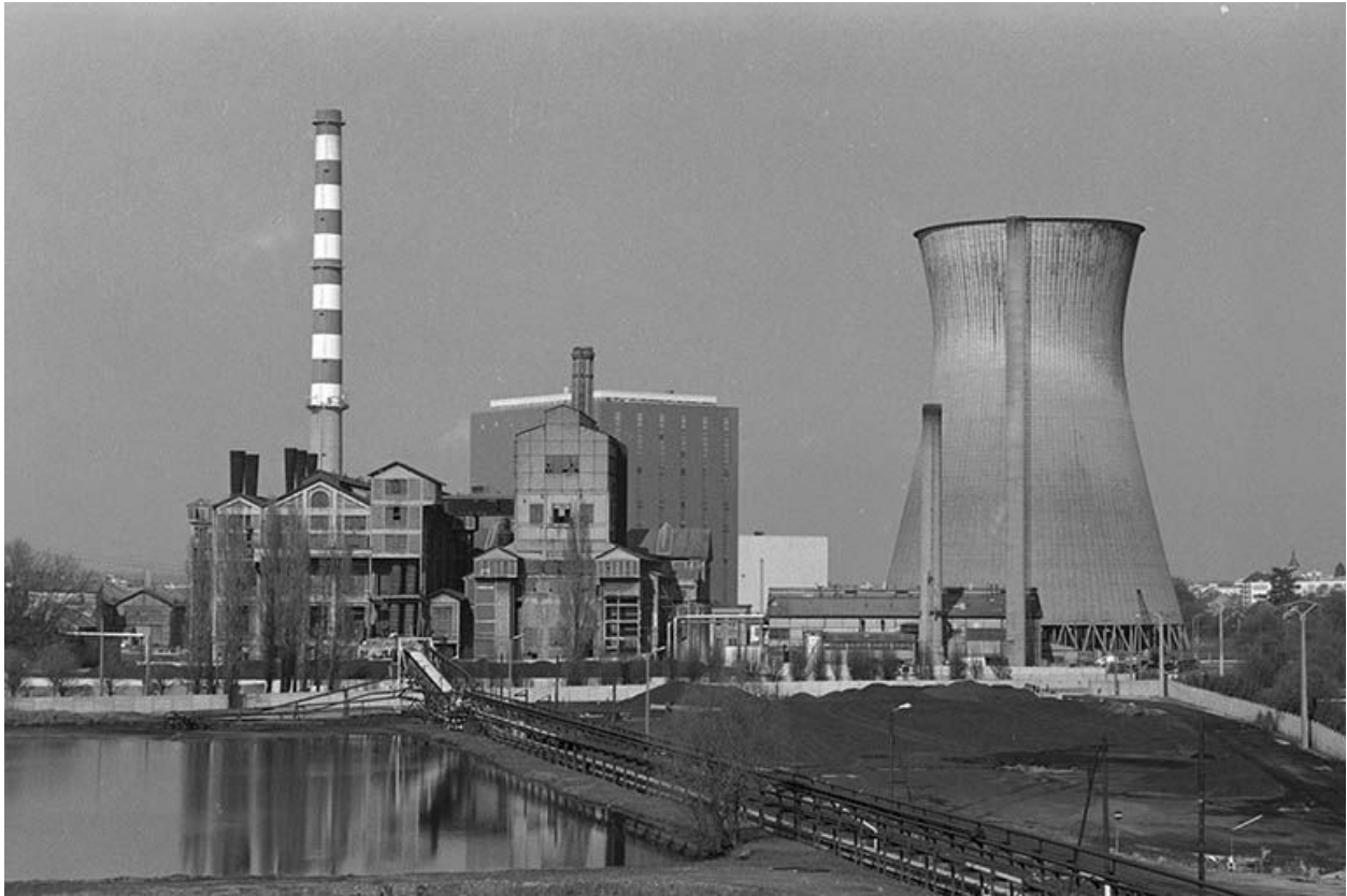
Les chaufferies de la centrale thermique de Lucy II photographiées depuis l'estacade de rebroussement du Lavoir des Chavannes (an arrière plan : cheminée, salle des machines et tour de réfrigération de Lucy III).
