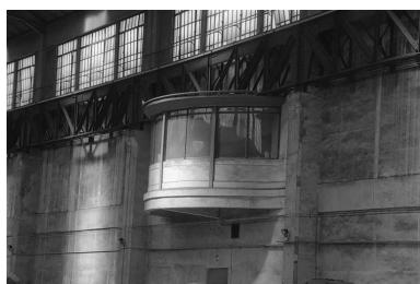
Le poste de contrôle de la salle des machines, installé dans le bâtiment des tableaux de distribution. Phot. Frédéric Pillet IVR26_20007100387Z
