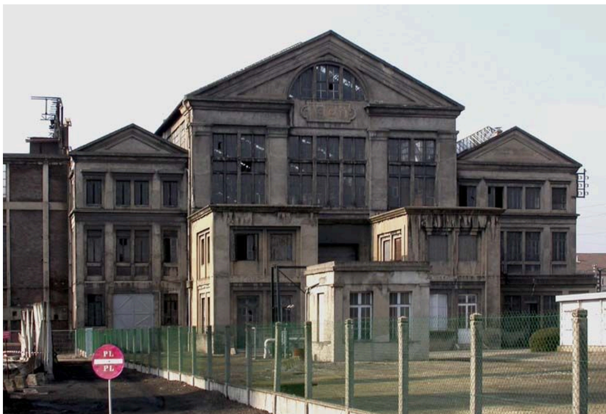
Elévation principale du bâtiments des alternateurs.
