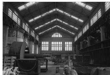
Pignon sud-est de la salle des machines vu depuis l'ancienne plate-forme des turbo-alternateurs. Phot. Frédéric Pillet IVR26_20007100383Z
