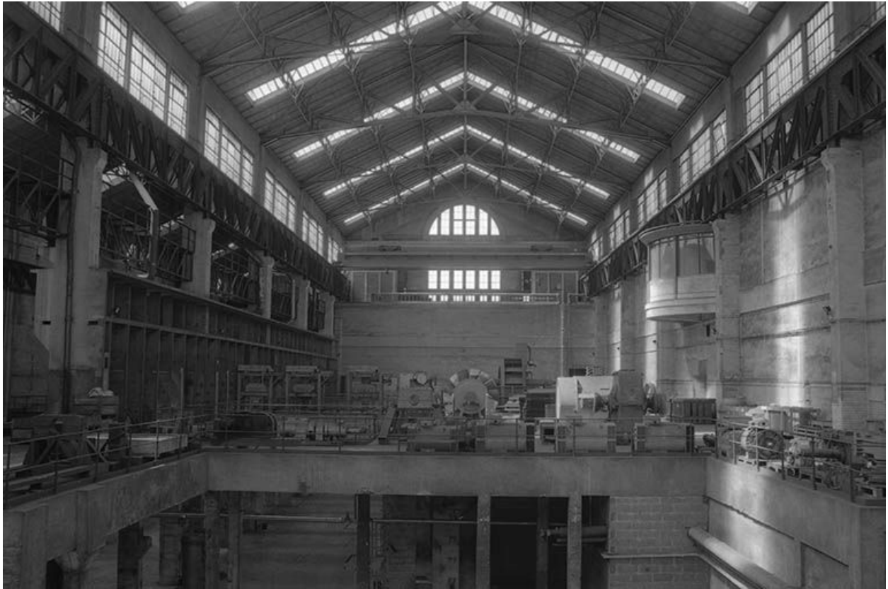
Pignon nord-ouest de la salle des machines vu depuis l'ancienne plate-forme des turboalternateurs.
