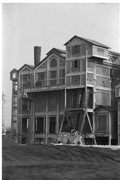
La chaufferie de Lucy II construite en 1923-1924, pignons sud.
