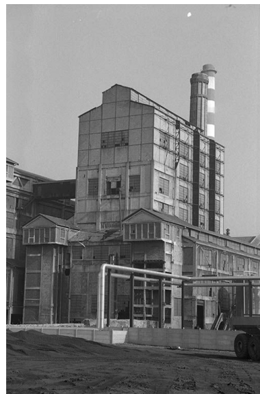
La chaufferie de Lucy II construite en 1919-1920 et son extension, pignons sud.
