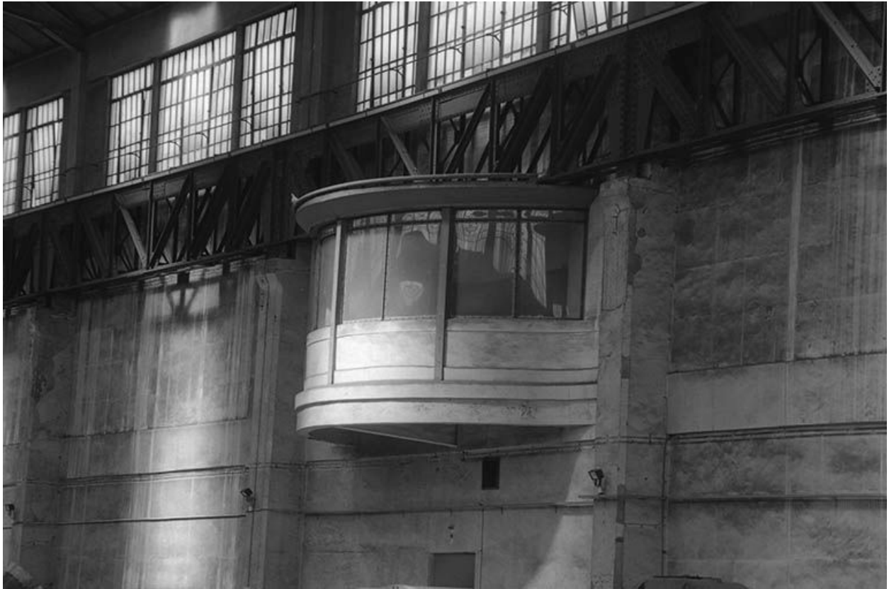
Le poste de contrôle de la salle des machines, installé dans le bâtiment des tableaux de distribution.
