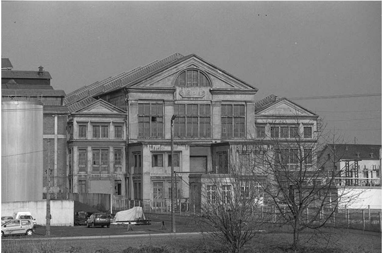
Façade antérieure de la centrale thermique de Lucy II vue depuis le canal du Centre.
