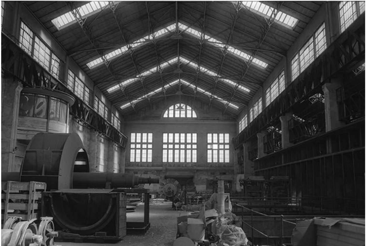
Pignon sud-est de la salle des machines vu depuis l'ancienne plate-forme des turbo-alternateurs.
