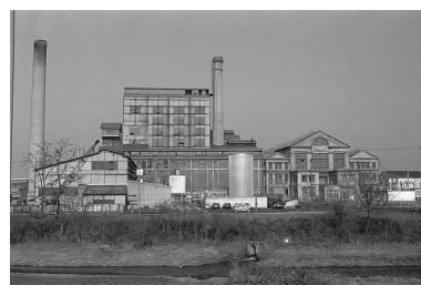
Le site de la centrale thermique de Lucy II vu depuis le canal du Centre.
