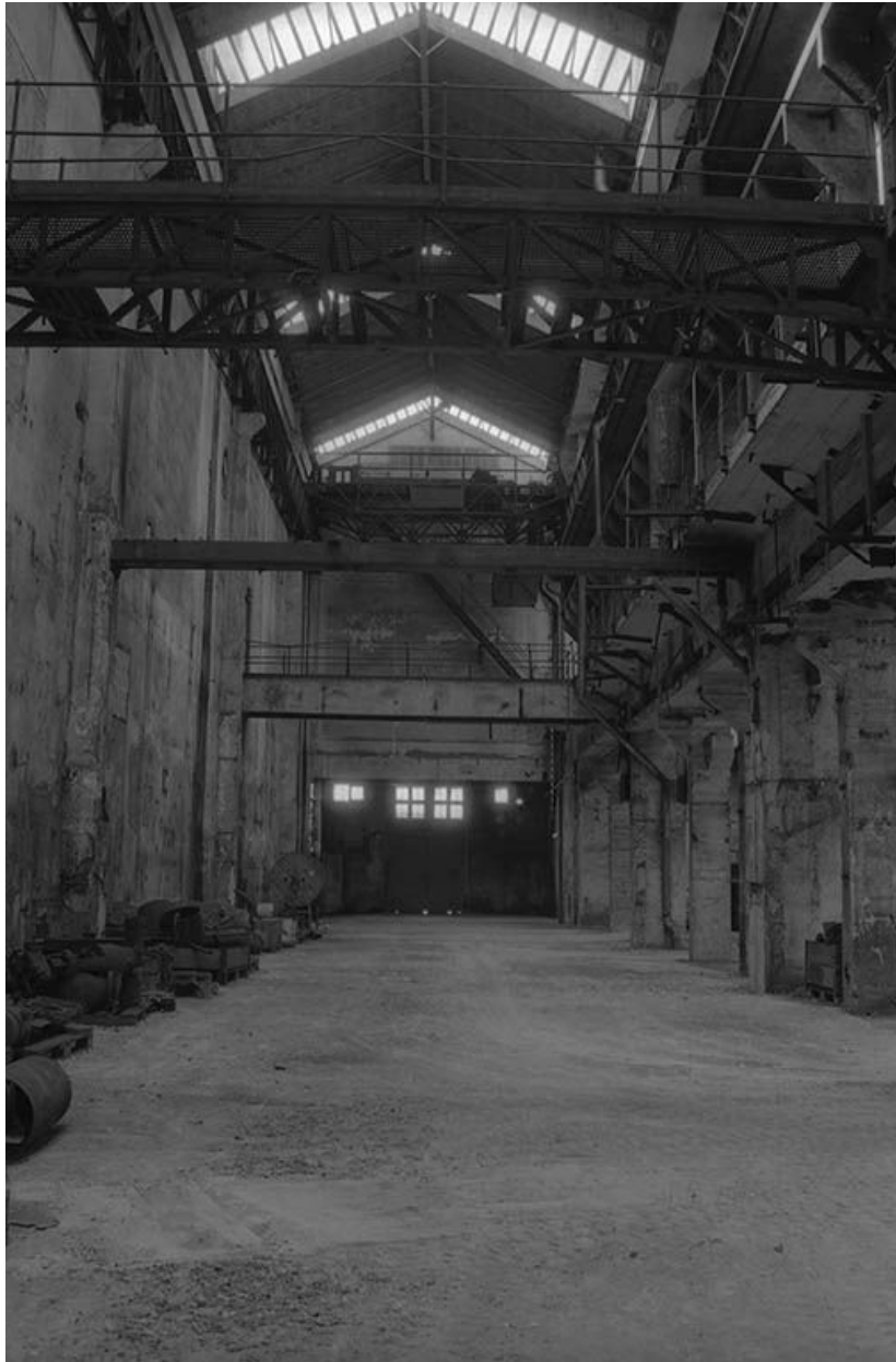
La salle des pompes (vue du pignon est).
