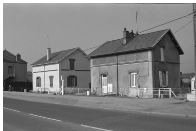
Logements ouvriers quai de Moulins (types 8). Phot. Frédéric Pillet IVR26_20007100398Z
