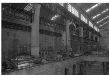
Le bâtiment des pompes vu depuis la salle des machines (ancienne plate-forme des turboalternateurs). Phot. Frédéric Pillet IVR26_20007100385Z
