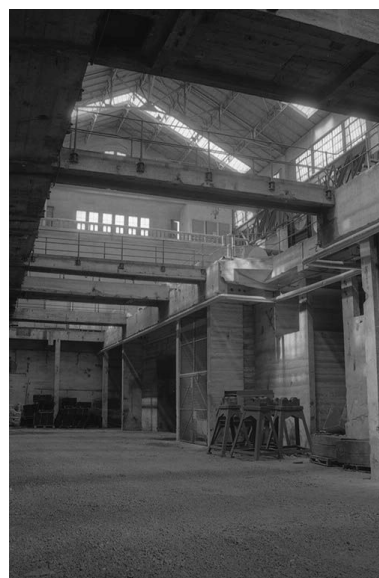
La salle des machines et les massifs formant la plate-forme des turboalternateurs. Phot. Frédéric Pillet IVR26_20007100386Z
