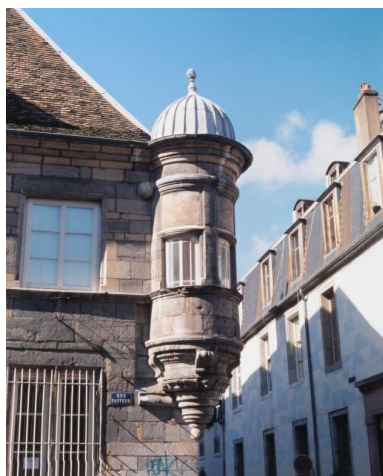
Façade latérale gauche : vue d'ensemble.
