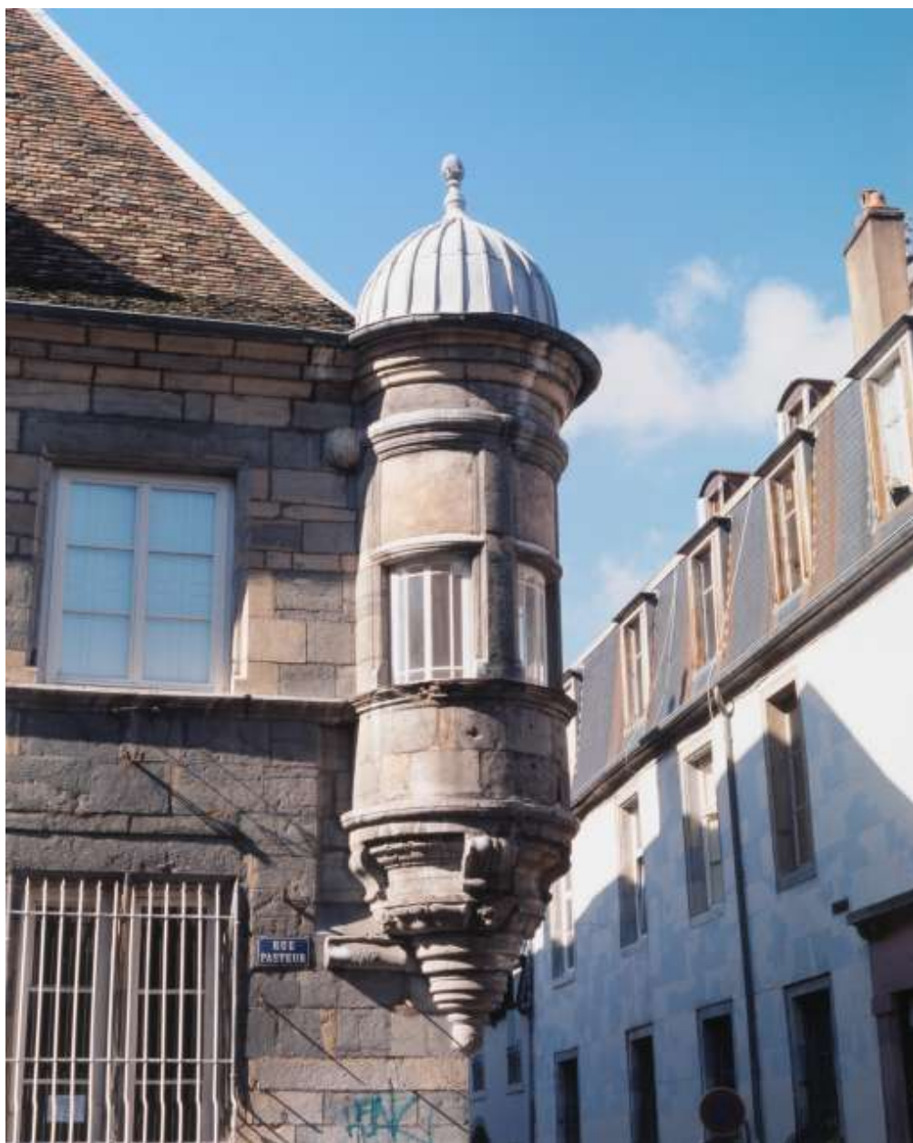
Façade latérale gauche : vue d'ensemble.
