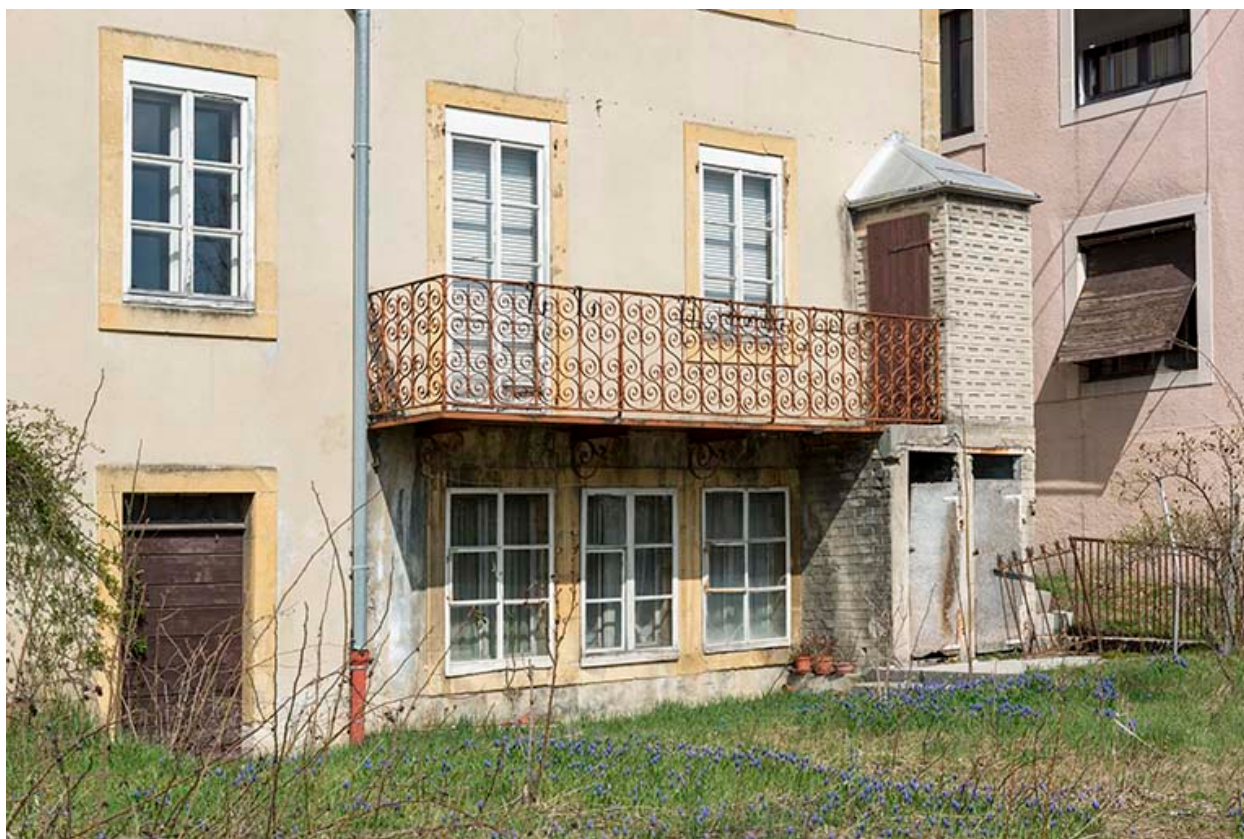
Façade postérieure en hiver : fenêtrages multiples et balcon.
