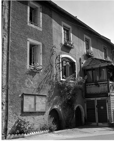
Façade postérieure. Phot. Yves Sancey IVR43_19802500991X
