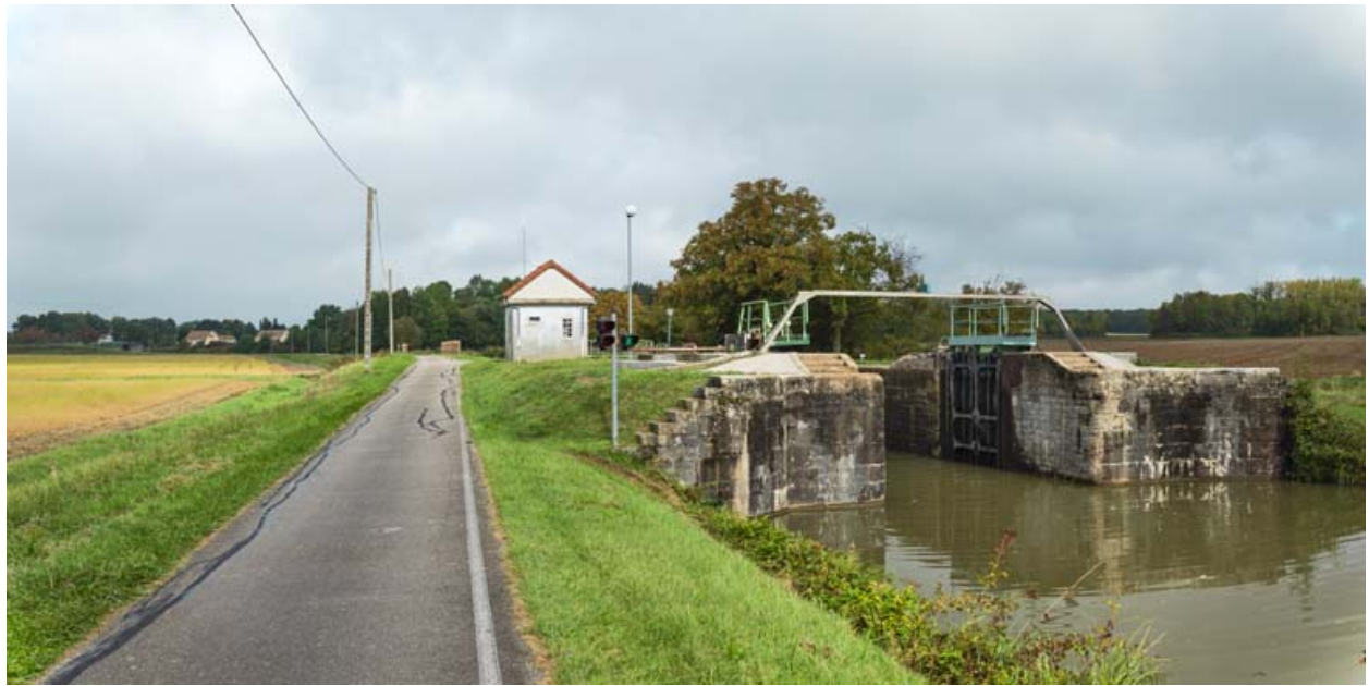
Vue de l'écluse.
