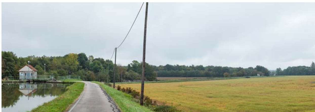
Vue d'ensemble du site d'écluse.
