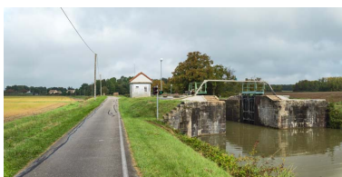
Vue de l'écluse. Phot. Pierre-Marie Barbe-Richaud IVR26_20177100441NUC2AQ
