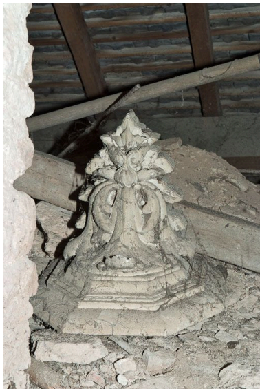
Vue d'ensemble d'une console. Phot. Pierre-Marie Barbe-Richaud IVR26_20112100264NUC2A
