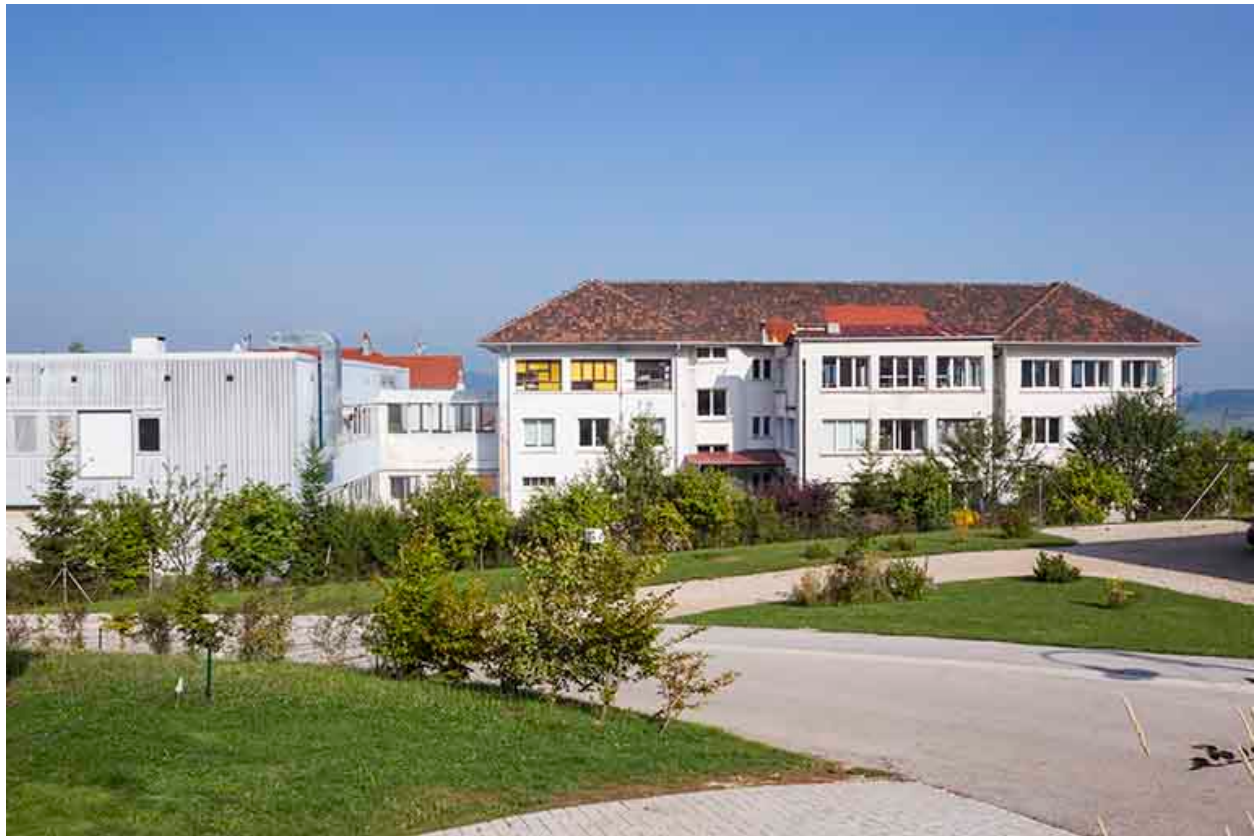
Ateliers de 1952 et 1970-1971 : façade postérieure.
