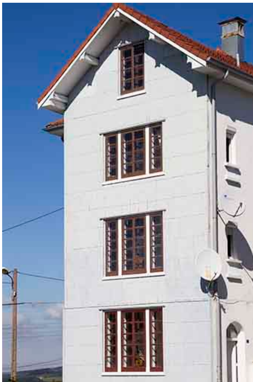
Atelier de 1948 : baies du mur pignon oriental.
