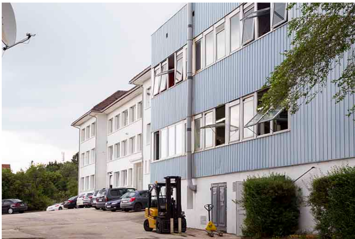
Ateliers de 1952 et 1970-1971, vus de l'entrée.
