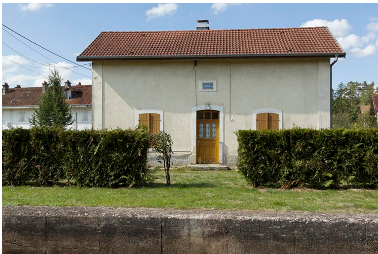
Vue de face de la maison d'éclusier.
