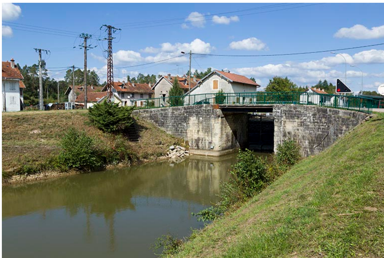
Depuis l'aval, vue sur le pont routier.
