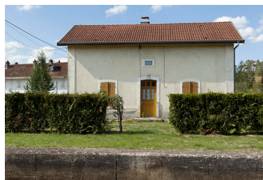
Vue de face de la maison d'éclusier. Phot. Sonia Dourlot IVR43_20157000956NUC2A
