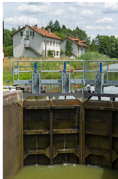
Détail intérieur de la porte amont fermée et vue sur les cités. Phot. Sonia Dourlot IVR43_20157000960NUC2A
