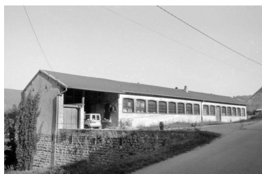
Façade antérieure. Phot. Laurent Poupard IVR43_19913901188Z
