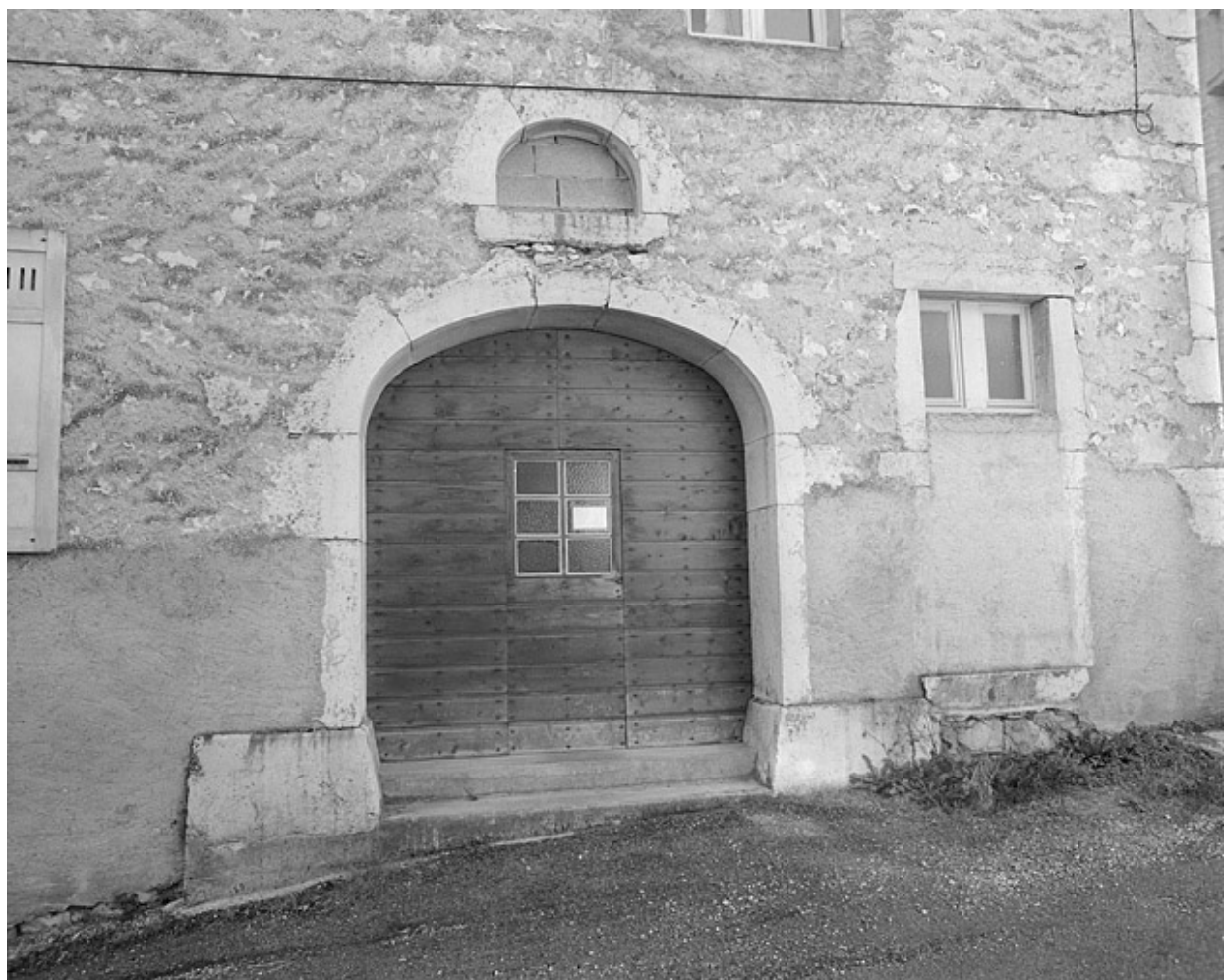
Bureau : porte dans le mur pignon nord-ouest.
