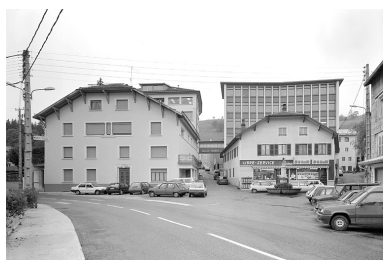
Place Dalloz, logement patronal. Phot. Jérôme Mongreville IVR43_19923900809V
