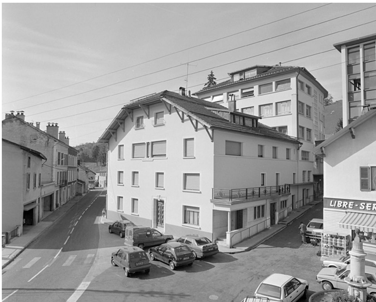
Logement patronal et usine (E).
