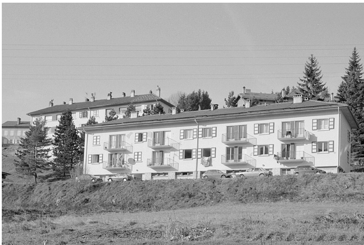
Logement d'ouvriers, depuis le sud-est.
