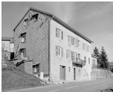
Façade antérieure et face sud-ouest. Phot. Jérôme Mongreville IVR43_19963901646X
