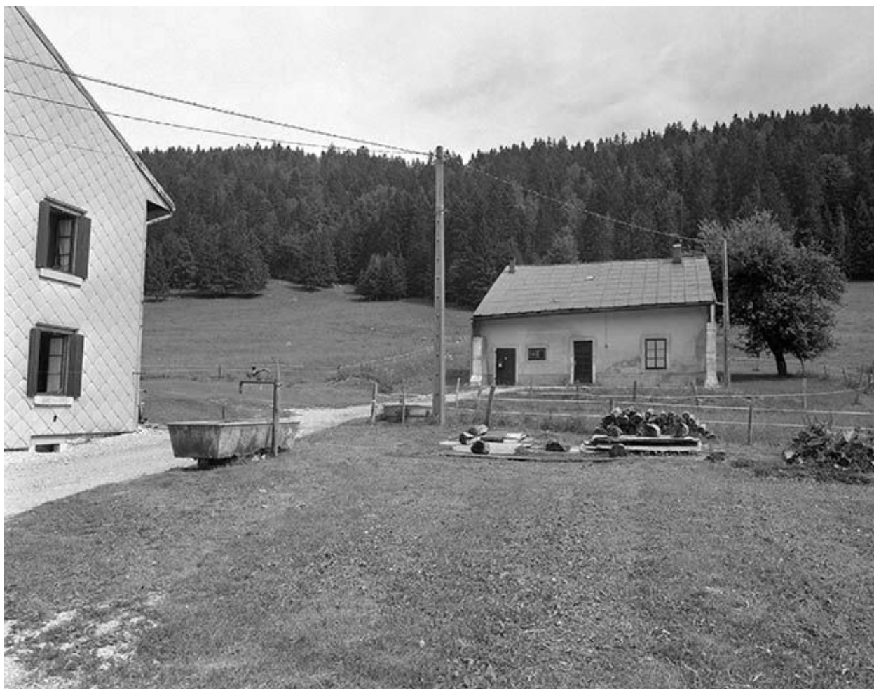
Vue générale depuis la route.
