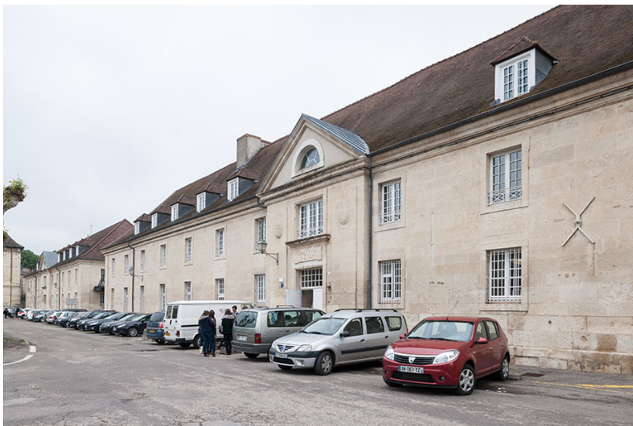
Bâtiment restauration-externat : façade postérieure.
