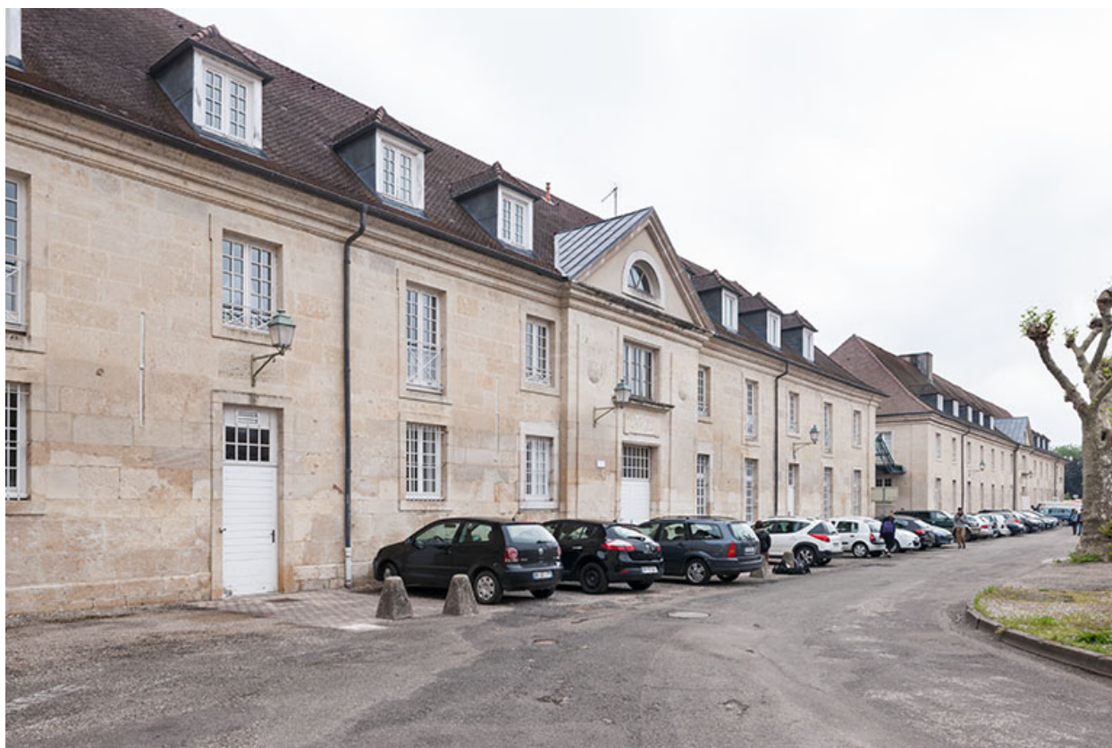
Bâtiment atelier-logement : façade postérieure, vue 3/4.
