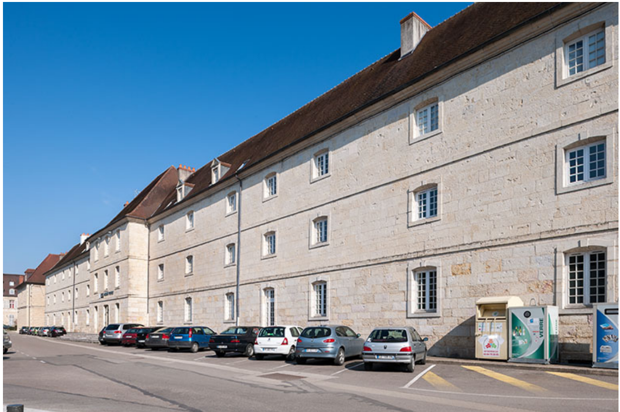
Externat : façade postérieure, place Barberousse.
