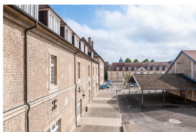
Plae Précipiano, partie nord : au premier plan le bâtiment
