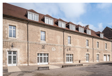
Atelier-externat : façade antérieure, place Précipiano. Phot. Jérôme Mongreville IVR43_20143900279NUC4A
