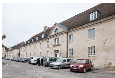
Bâtiment restauration- externat : façade postérieure. Phot. Jérôme Mongreville IVR43_20143900285NUC4A
