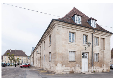
Bâtiment restauration- externat, pignon sud. Phot. Jérôme Mongreville IVR43_20143900284NUC4A
