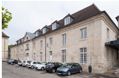
Bâtiment atelier-logement : vue 3/4 depuis le sud. Phot. Jérôme Mongreville IVR43_20143900287NUC4A
