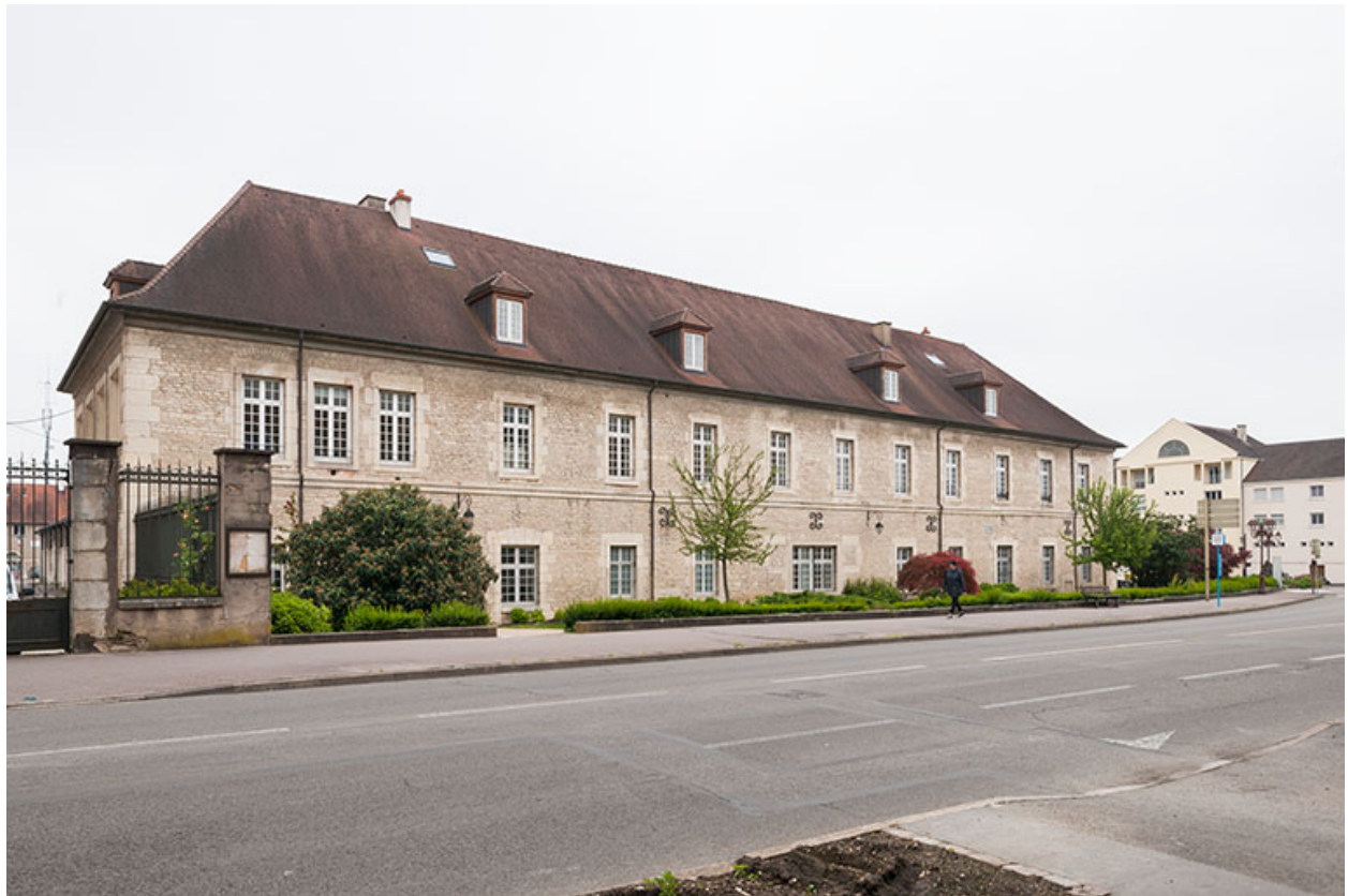
Atelier-externat : façade sur la rue des Arènes.
