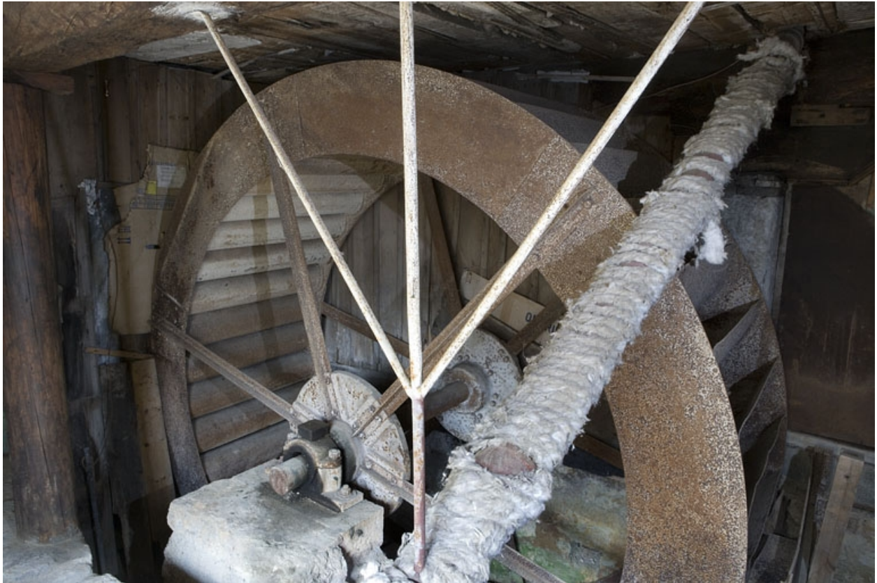
Roue hydraulique verticale, depuis l'amont.
