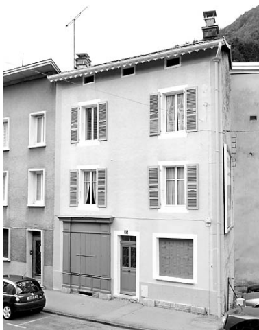
Façade antérieure de la maison. Phot. Yves Sancey IVR43_20033900247X
