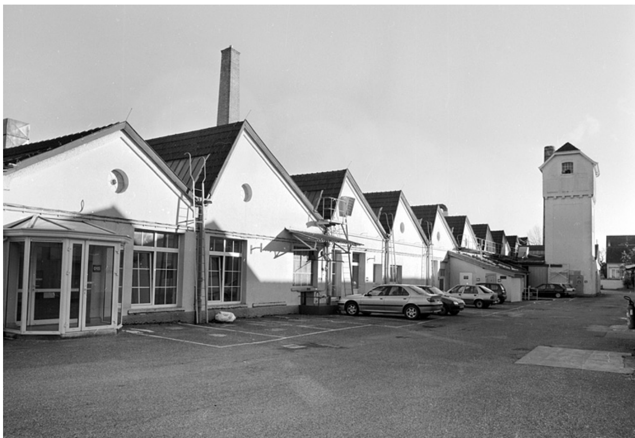
Pignons ouest de l'atelier de fabrication.
