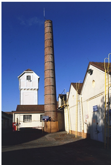
Réservoir industriel, cheminée et entrepôt industriel. Phot. Jérôme Mongreville IVR43_20019000605ZA
