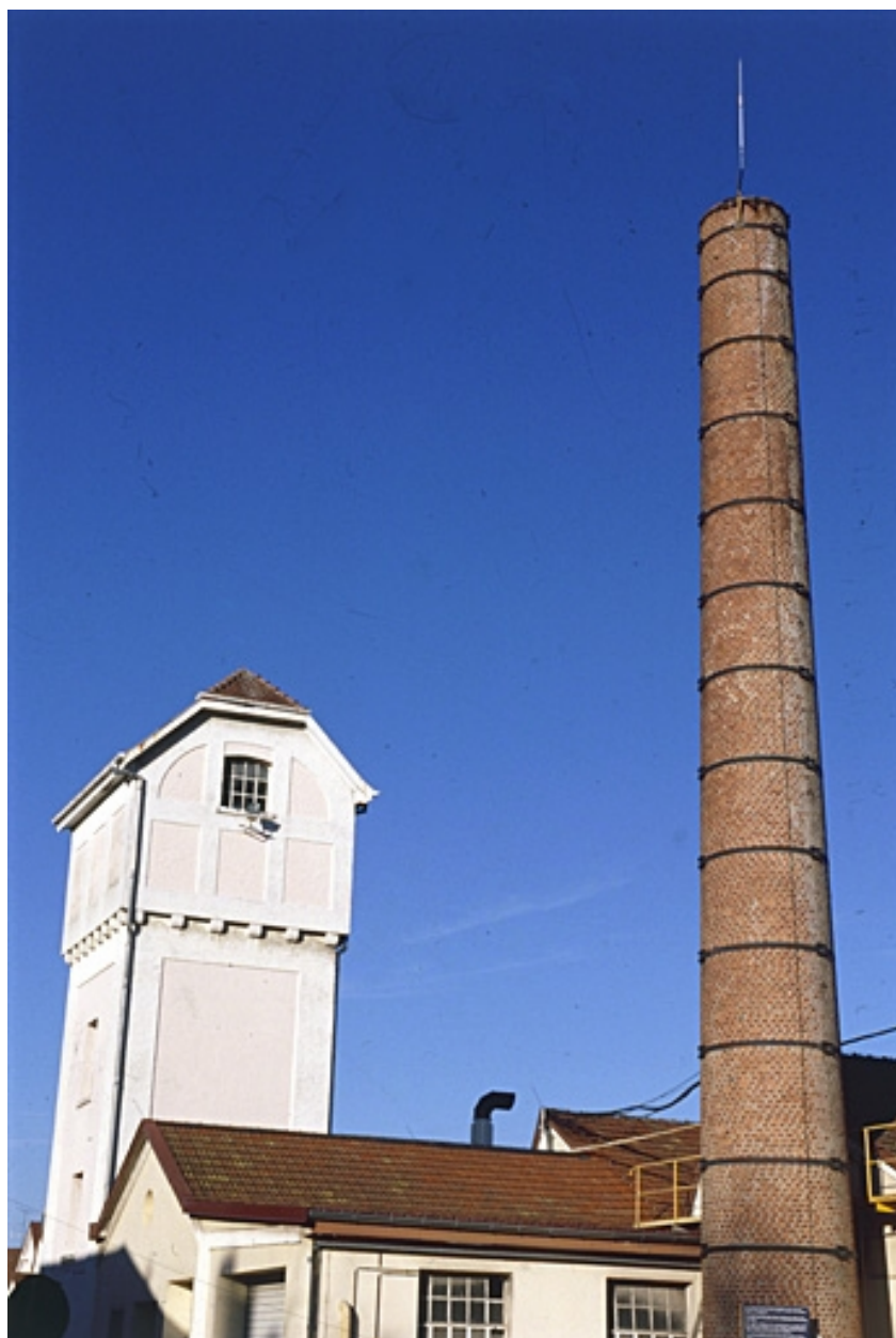
Réservoir industriel et cheminée depuis le sud-ouest.
