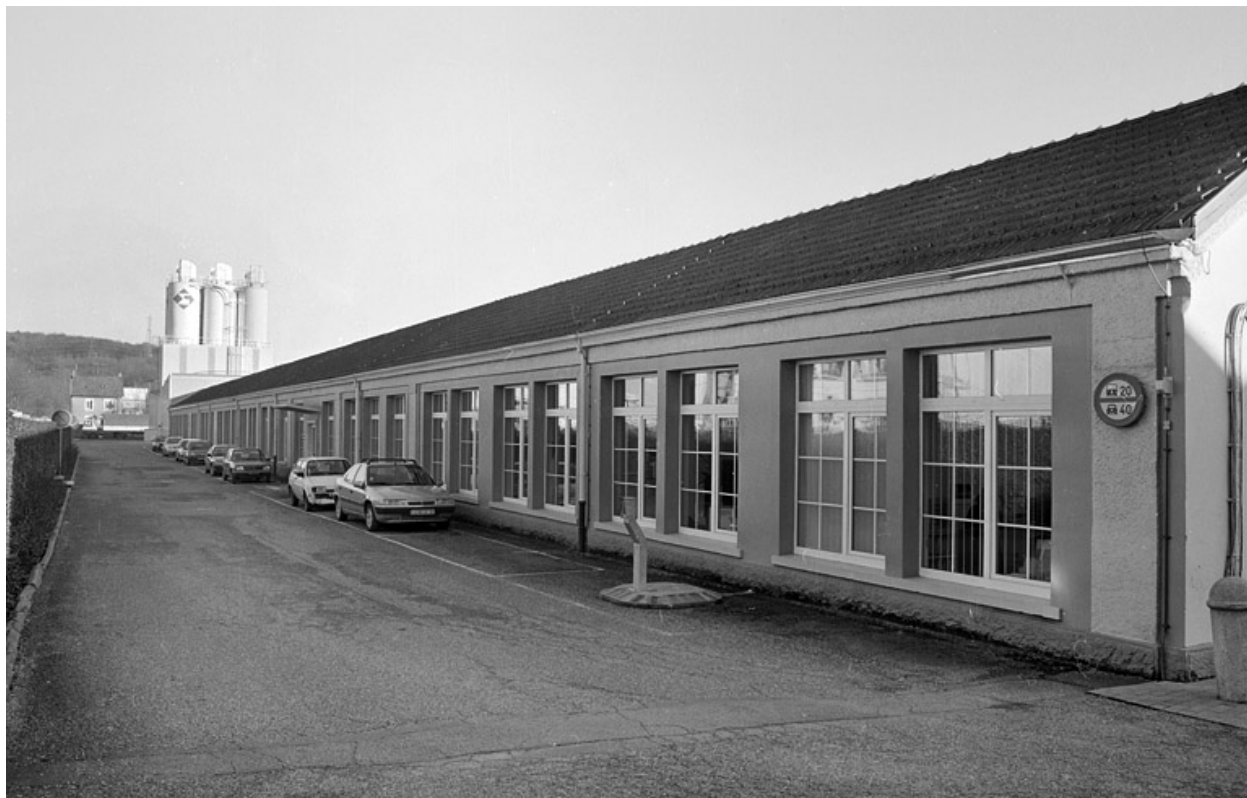
Façade nord de l'atelier de fabrication.
