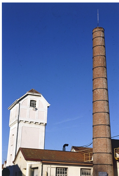
Réservoir industriel et cheminée depuis le sud-ouest. Phot. Jérôme Mongreville IVR43_20019000603ZA
