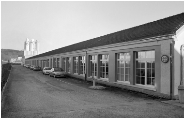
Façade nord de l'atelier de fabrication.
