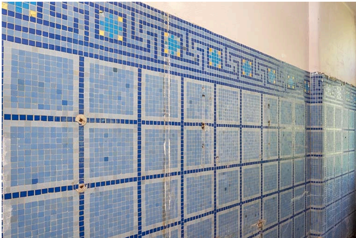
Mur sud de la dernière cabine (actuellement, local de stockage) au rez-de-chaussée de l'aile ouest de la piscine.
