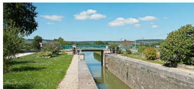
Vue du pont depuis l'amont. Phot. Pierre-Marie Barbe-Richaud IVR26_20112103691NUC4AQ
