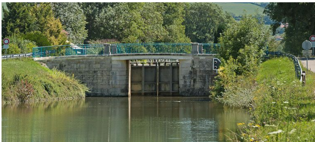
Vue du pont depuis l'aval.
