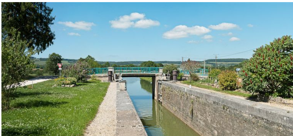
Vue du pont depuis l'amont.
