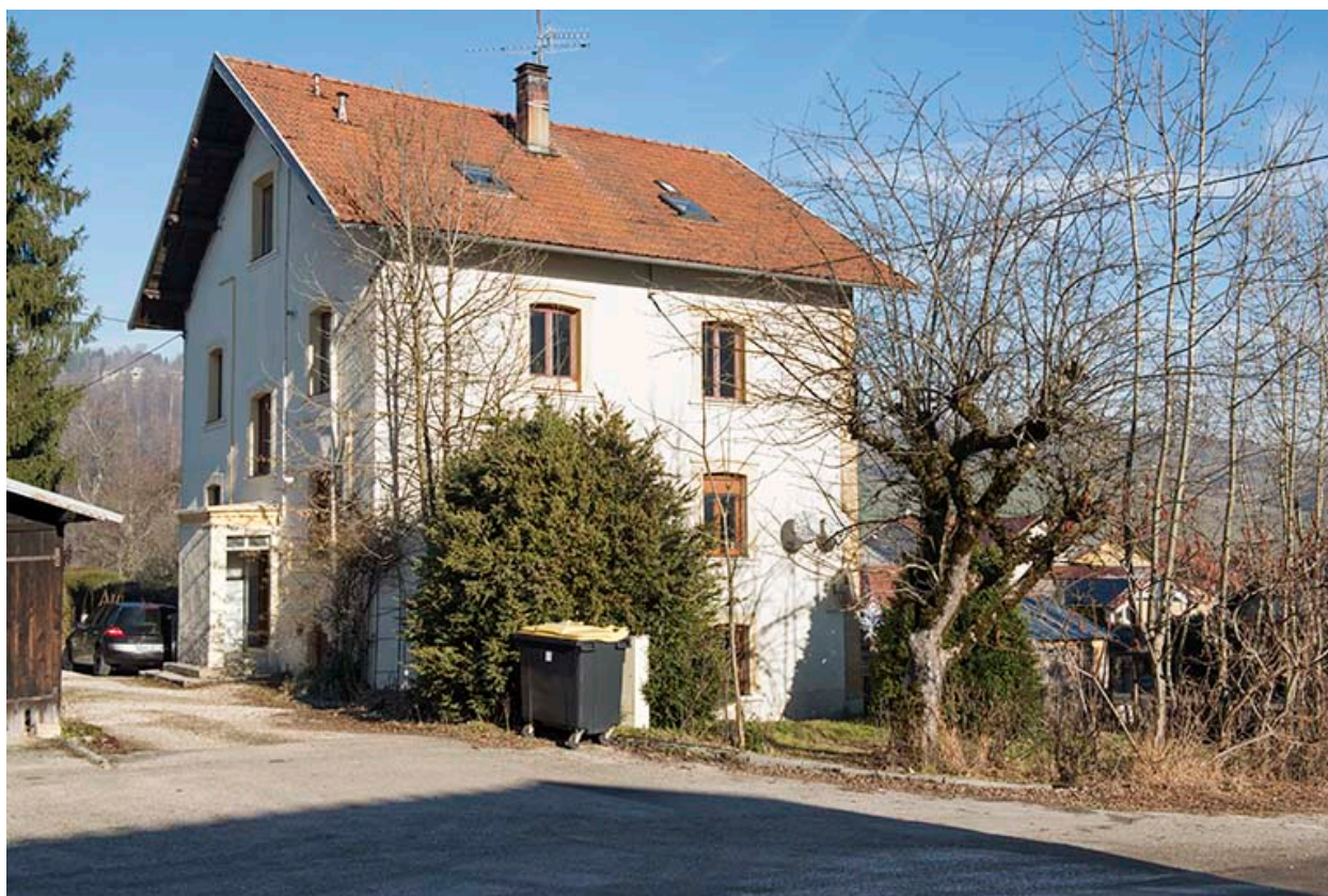
Façades postérieure et latérale gauche.
