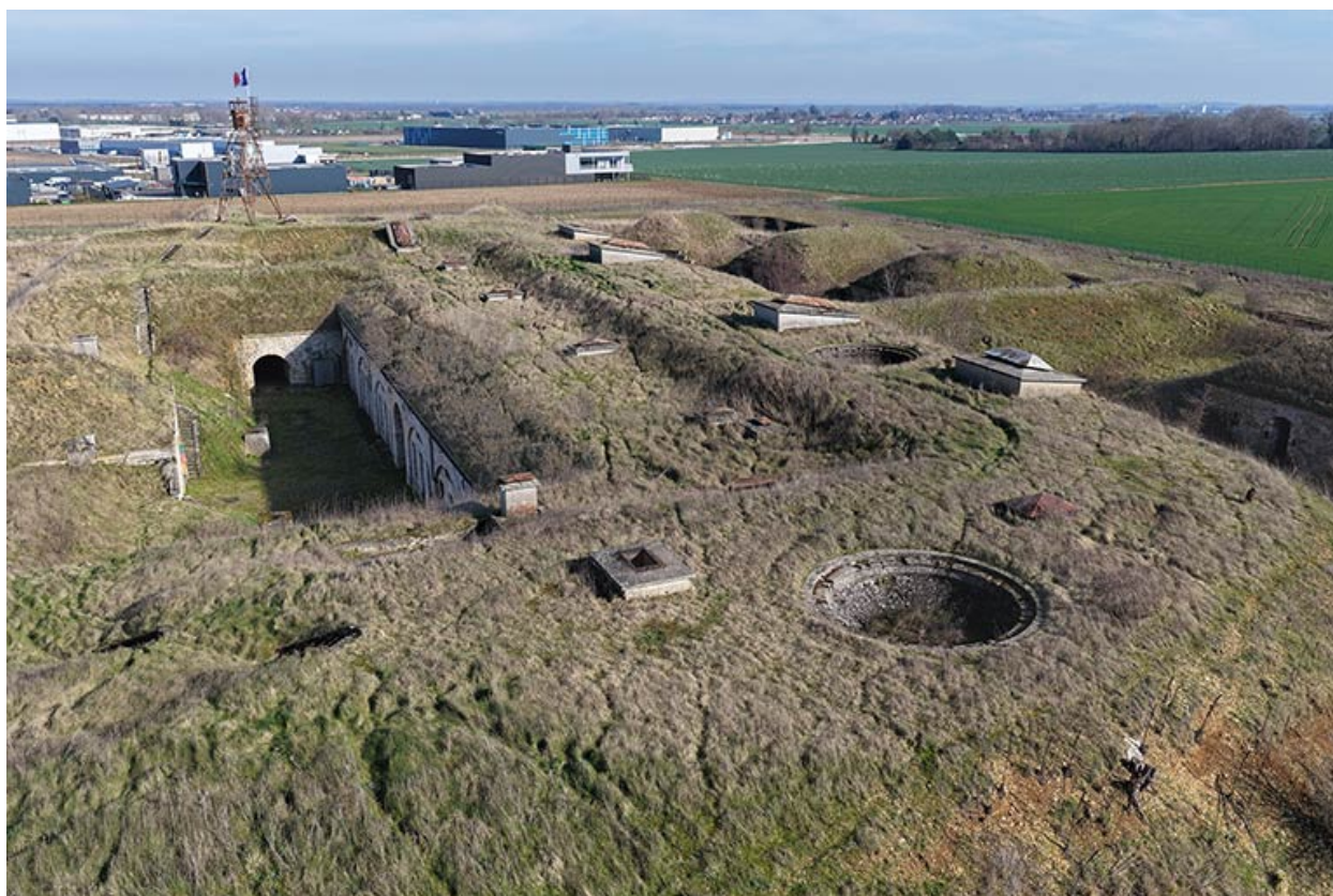
Cuve pour canon anti-aérien. (vue aérienne).
