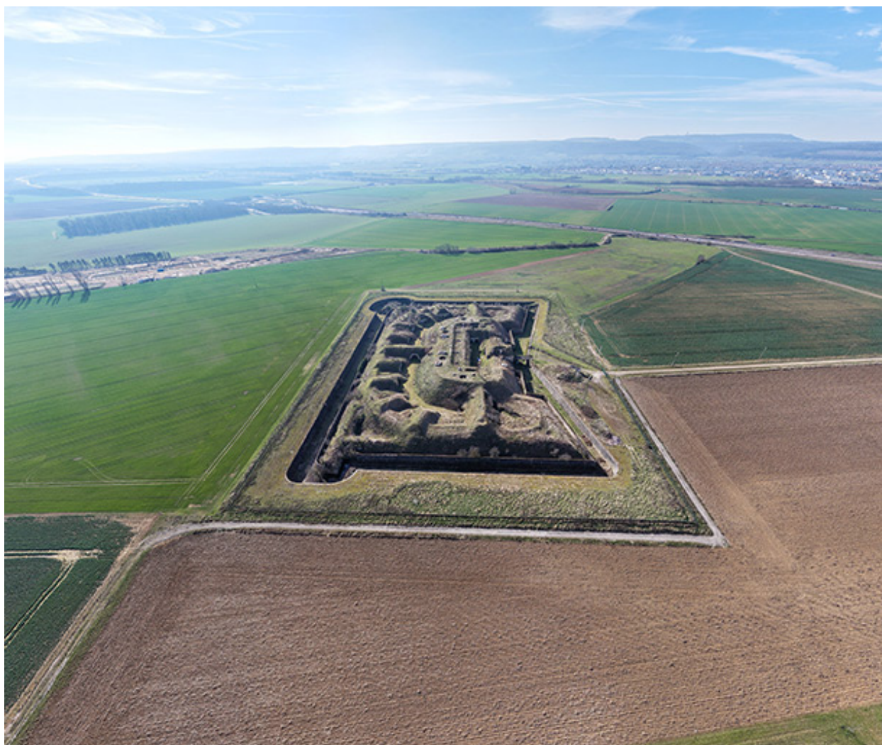
Vue nord. (vue aérienne).
