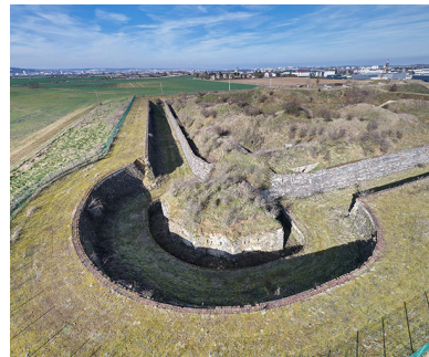
La double caponnière, au saillant 3. (vue aérienne). Phot. Nicolas Douriaux IVR26_20262100336NUC4A
