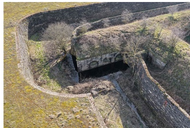
La caponnière (ou aileron) simple au saillant 2. (vue aérienne). Phot. Nicolas Douriaux IVR26_20262100377NUC4A
