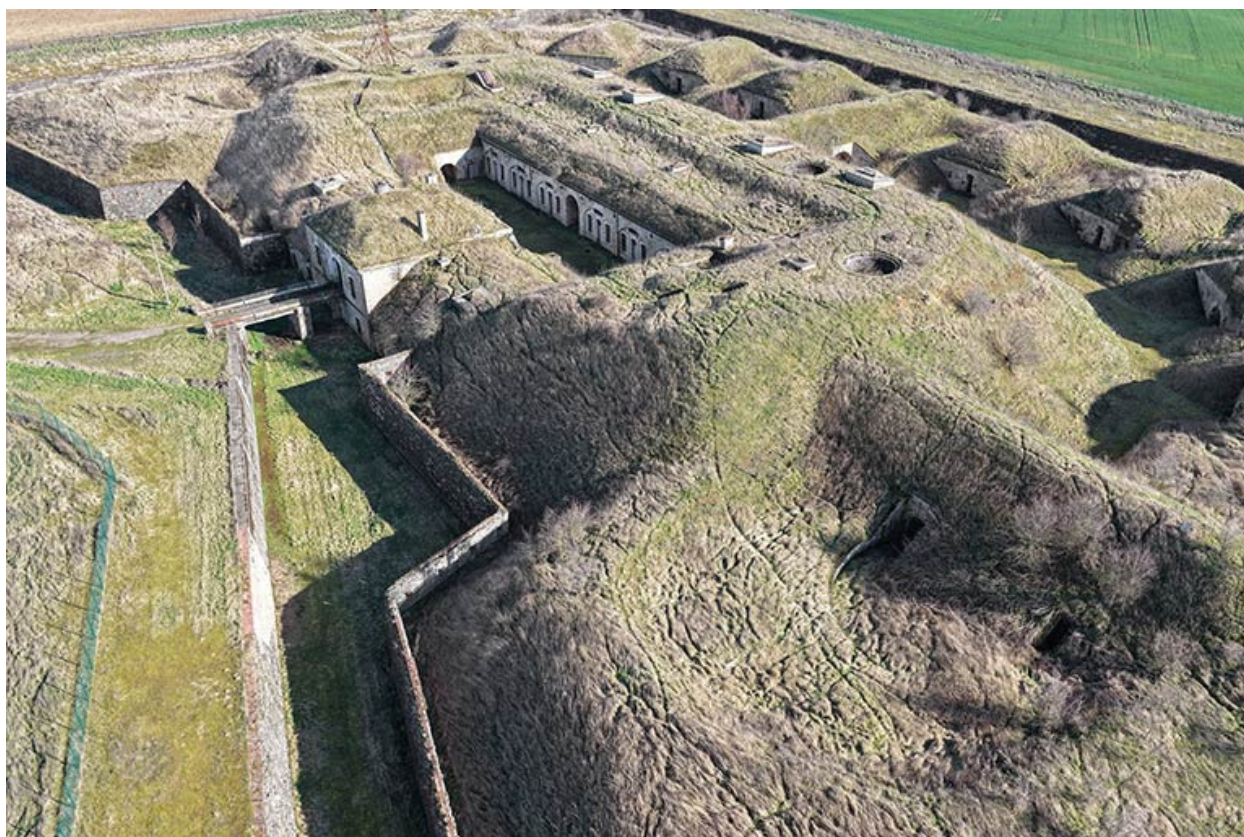
Le fossé à la gorge du fort et son escarpe de type Carnot. (vue aérienne).
