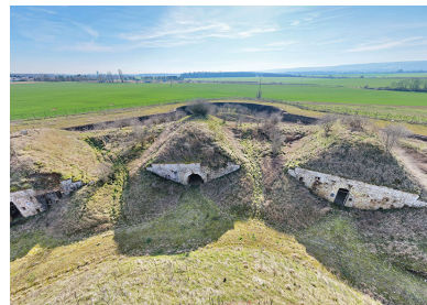
Les traverses-abris et plateformes de tir au front d'attaque. (vue aérienne). Phot. Nicolas Douriaux IVR26_20262100372NUC4A
