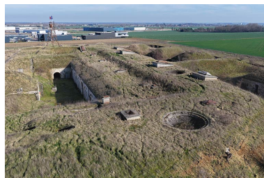
Cuve pour canon anti-aérien. (vue aérienne). Phot. Nicolas Douriaux IVR26_20262100373NUC4A
