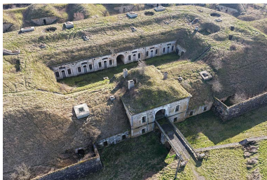
Le bâtiment d'entrée et l'espace de casernement. (vue aérienne). Phot. Nicolas Douriaux IVR26_20262100380NUC4A
