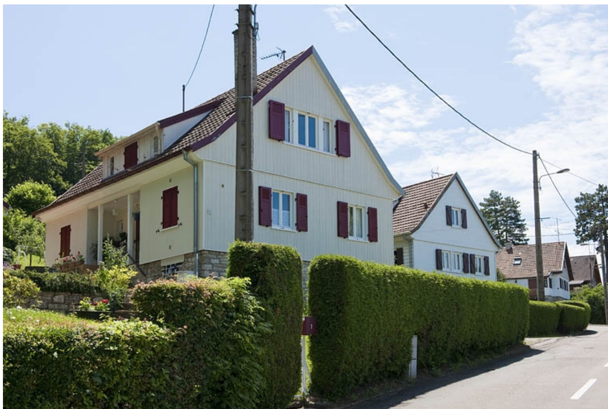
Pignons ouest des maisons rue Raoul Delattre.
