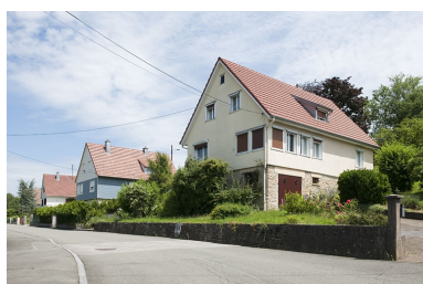
Maisons individuelles rue Robert Bernard. Phot. Jérôme Mongreville IVR43_20122501254NUC4A
