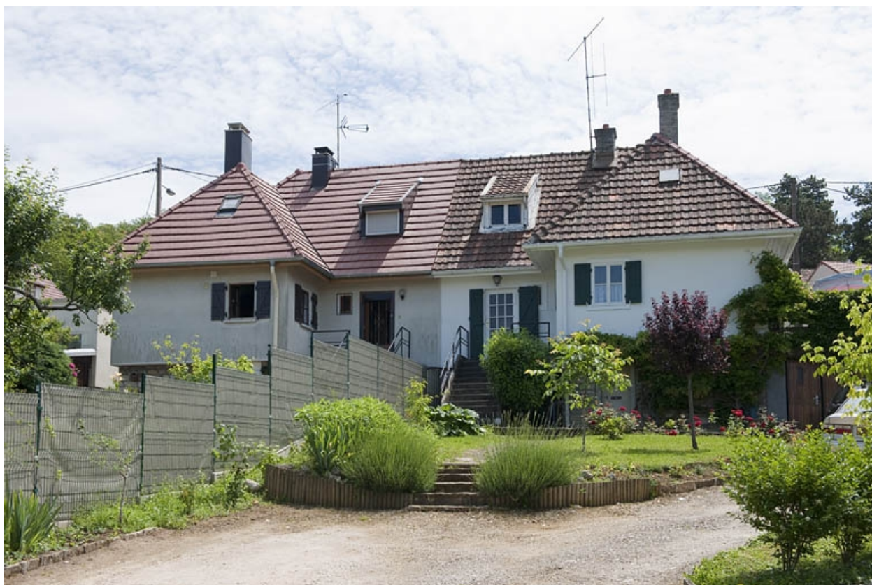
Maisons jumelles rue Raoul Delattre. Façades ouest.
