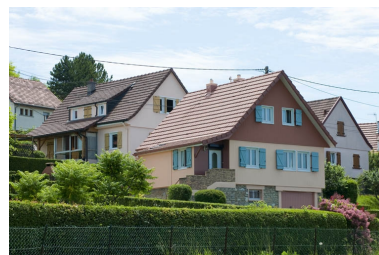
Maisons individuelles à flanc de colline. Phot. Jérôme Mongreville IVR43_20122501257NUC4A
