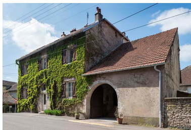
La grange, adossée au mur pignon Nord. Phot. Jérôme Mongreville IVR43_20177000704NUC4A
