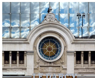
Façade antérieure, étage (en 2005) : décor et oculus. Phot. Alain Morelière IVR26_20052101941NUC2A
