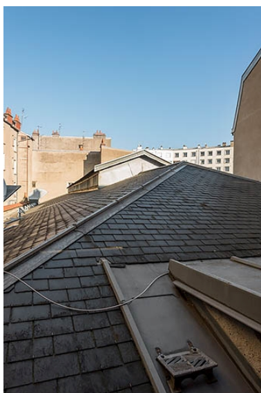
Le toit du cinéma, vu depuis la façade écran. Phot. Pierre-Marie Barbe-Richaud IVR26_20212100324NUC4A
