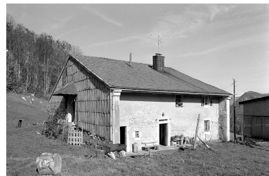
La ferme de la Rapine. Phot. Jérôme Mongreville IVR43_19963901673X
