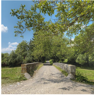
Le pont : vue du dessus. Phot. Thierry Kuntz IVR26_20135800276NUC4A
