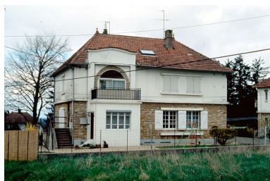
Maison (H) : façade postérieure. Phot. Yves Sancey IVR43_19943901627ZA
