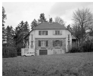
Maison (B) : façade antérieure. Phot. Yves Sancey IVR43_19943901618X
