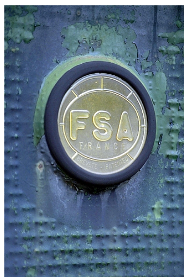
Remises d'automobile métallique : baie. Phot. Yves Sancey
