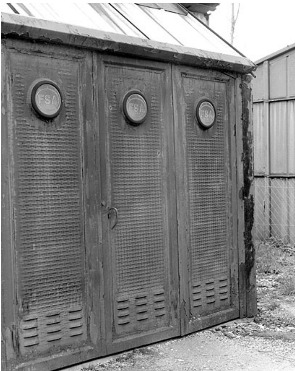
Remise d'automobile métallique : porte d'entrée.
