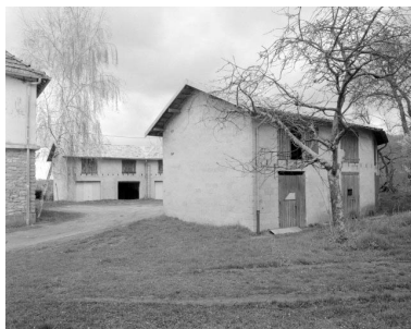
Remise d'automobile et bûcher (F) : vue d'ensemble. Phot. Yves Sancey IVR43_19943901631X
