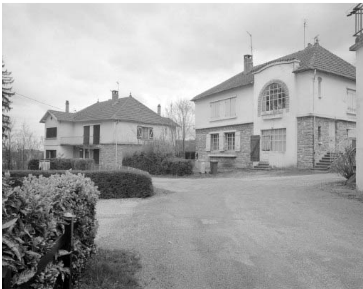
Maisons (G, D) : vue d'ensemble.
