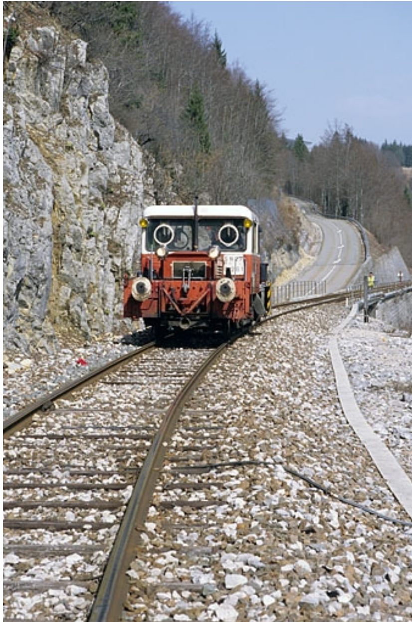
Vue d'ensemble de face. Chantier d'entretien de la voie à l'extrémité du viaduc des Crottes côté La Cluse (vers le PK 045.200). Chantier d'entretien de la voie à l'extrémité du viaduc des Crottes côté La Cluse (vers le PK 045.200).
