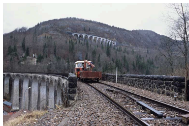
Draisine sur le viaduc de Morez. Phot. Yves Sancey IVR43_20053900514ZA
