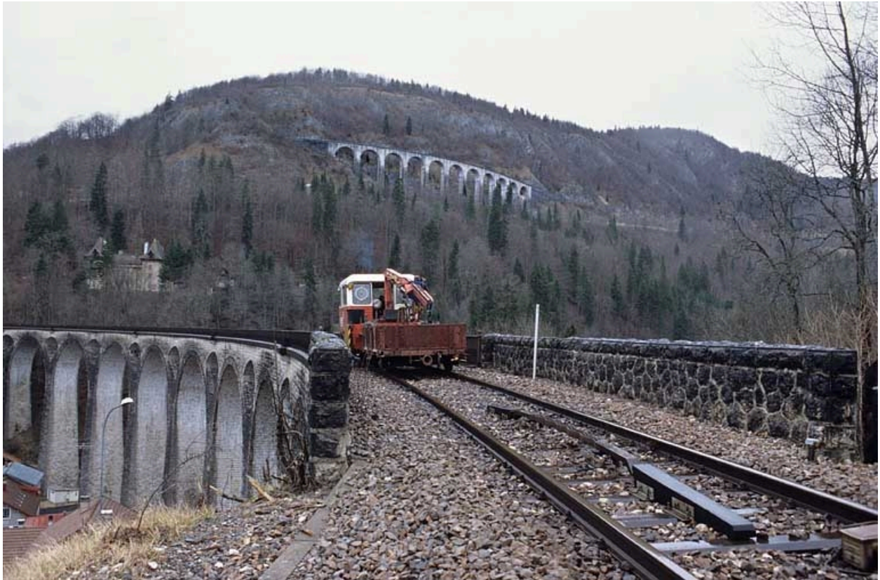
Draisine sur le viaduc de Morez.
