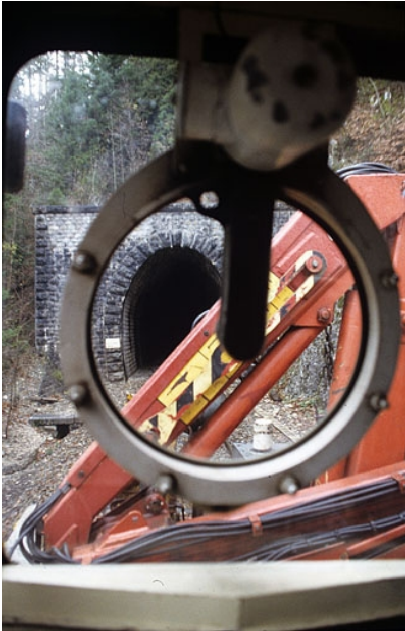
Hublot. Approche de la tête du tunnel de la Joux côté Andelot-en-Montagne (vers le PK 039.020). Approche de la tête du tunnel de la Joux côté Andelot-en-Montagne (vers le PK 039.020).
