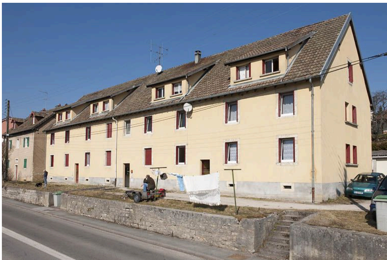
Immeuble d'habitation (10 logements).
