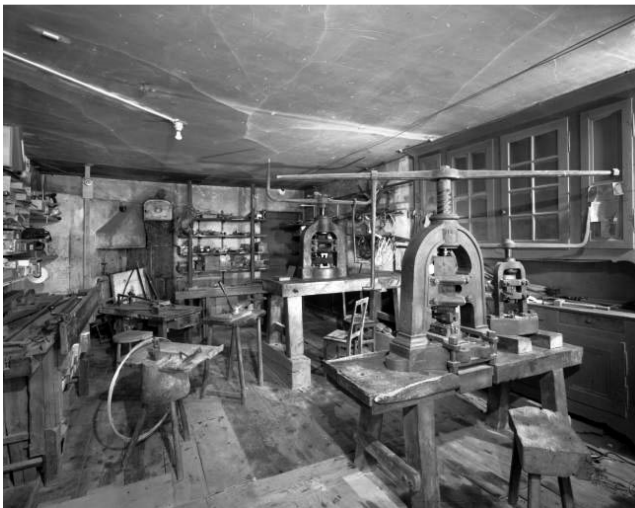
Intérieur de l'atelier de fabrication.
