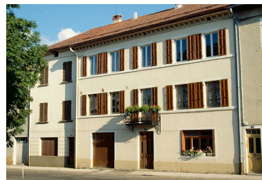
Façade antérieure. Phot. Laurent Poupard IVR43_19913900792ZA
