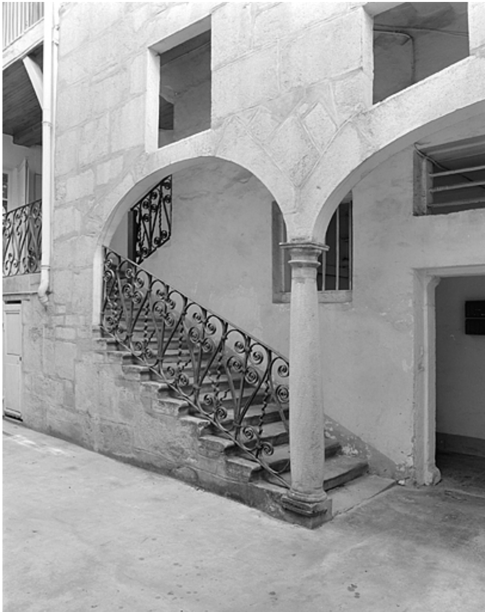
Départ de l'escalier s'ouvrant sur la cour.
