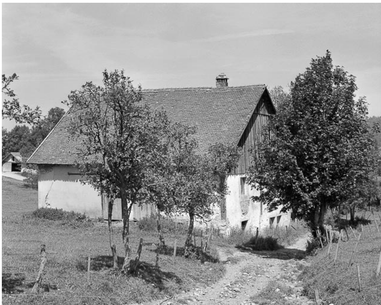
Façade antérieure et latérale gauche.
