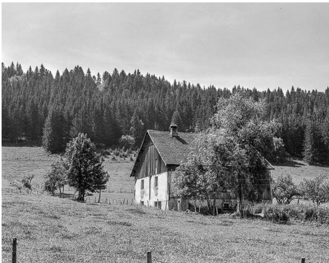
Façade latérale droite.
