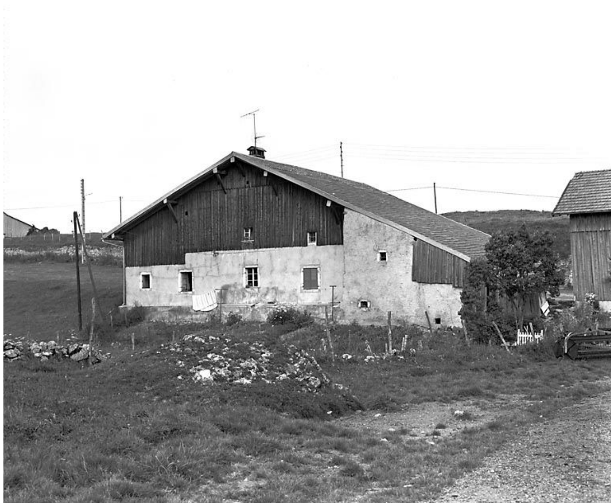
Ferme à Villedieu-les-Rochejean : façade latérale gauche.
