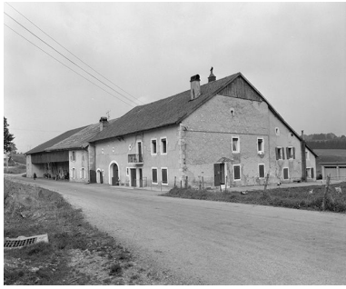
Fermes Villedieu-les-Rochejean : vue de trois quarts droit. Phot. Yves Sancey IVR43_19782500402X
