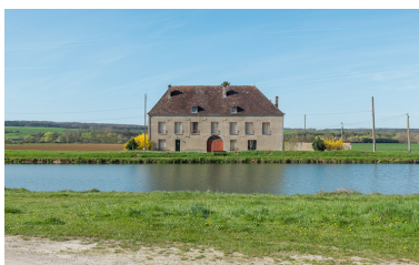
Le bâtiment couvert de tuile plate, sur le port. Phot. Pierre-Marie Barbe-Richaud IVR21_20131000166NUC4AQ
