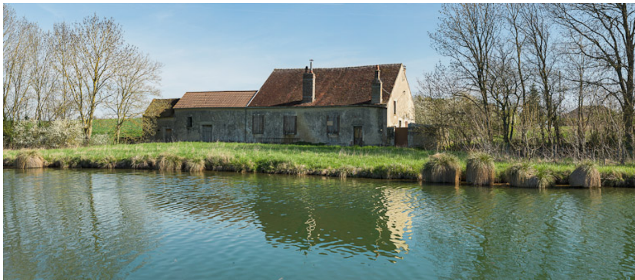
Les petits bâtiments en aval du port.
